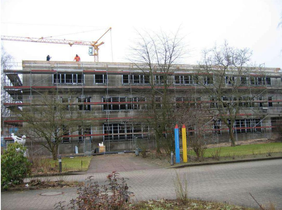
Der Rohbau steht und Fenster und Außentüren werden montiert (Februar/Juli 2012)
