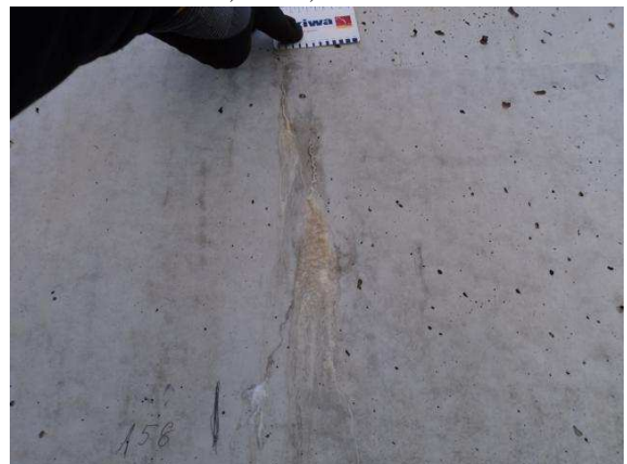
2018_RISSE MIT AUSSINTERUNGEN AM KOPFBALKEN
