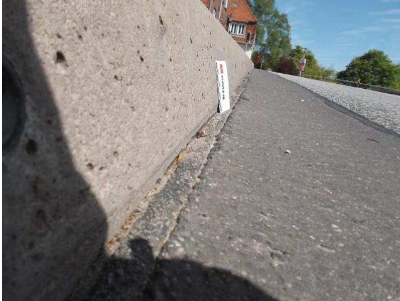
2018_FUGENFÜLLUNG ABGESACKT
