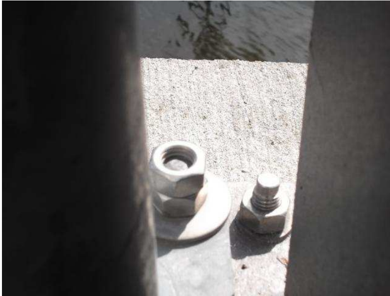
2018_VERANKERUNG DER BAUWERKSBELEUCHTUNG
