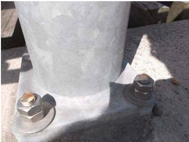
2018_BOLZEN ABGETRENNT
