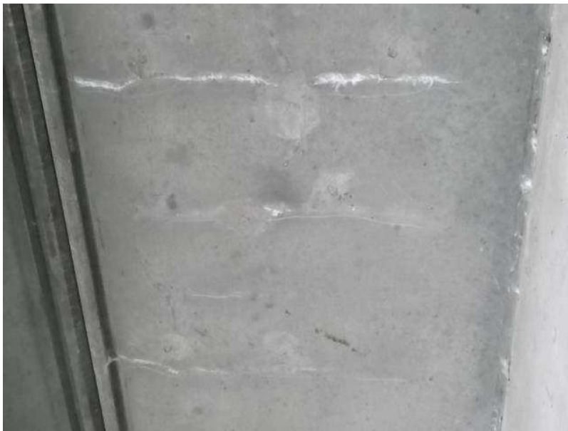
2018_RISSE AN PLATTE UNTERSEITIG MIT AUSSINTERUNGEN
