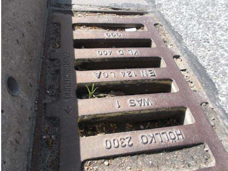
2018_BAUWERKSENTWÄSSERUNG VERSCHMUTZT
