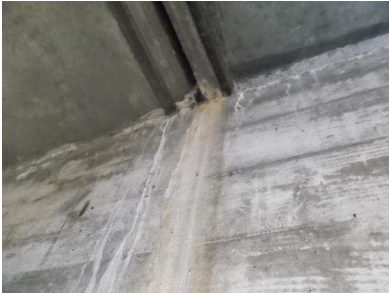
2018_AUSSINTERUNGEN IM BEREICH DES QUERTRÄGERS
