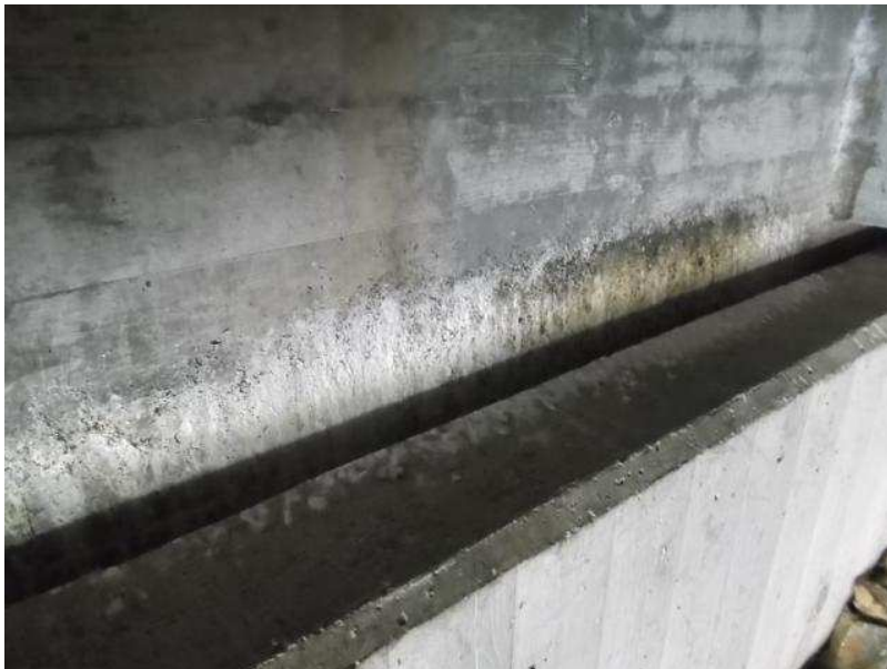
2018_AUSSINTERUNGEN VORN AM ENDQUERTRÄGER
