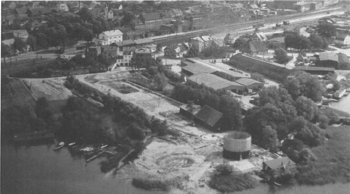
Abb. 3: Bereich der Landzunge um ca. 1950. Zu sehen ist bereits ein Faulturm auf der Spitze der Landzunge, die weiteren Anlagen des Klärwerks befinden sich noch im Bau. (Quelle: Stadtarchiv Mölln)
