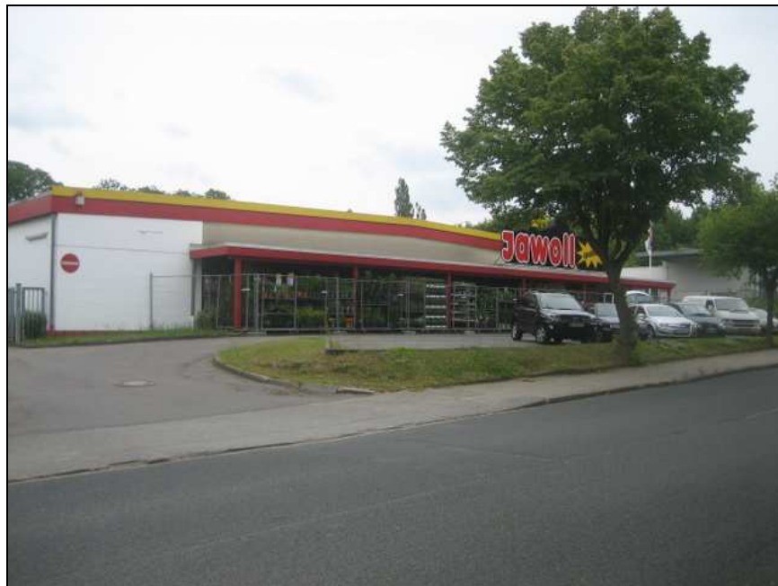
Abb. 2 Ansicht des Sonderpostenmarktes von der Heinrich-Hertz-Straße aus
