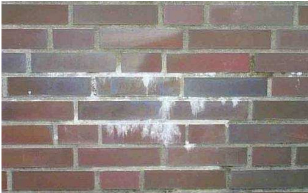
WIDERLAGERWAND HINTEN RECHTS
