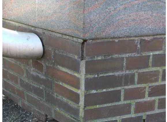
ECKE BRÜSTUNG-FLÜGELWAND LINKS
