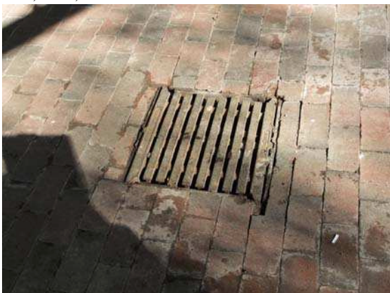
SCHACHTEINLAUF UNTERFÜHRUNG OSTEN
