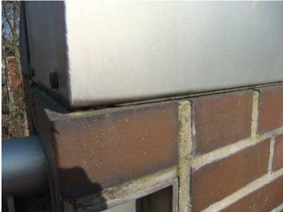
BELEUCHTUNGSEINRICHTUNG AUF BRÜCKENPFEILERN
