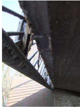
UNTERSEITE DES PLATTENÜBERBAUS NORDSEITE
