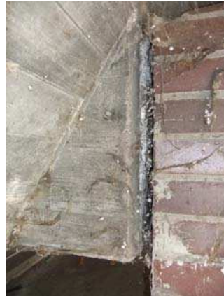
SYROPORFÜLLUNG NICHT VOLLSTÄNDIG ENTFERNT
