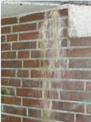
VERBLENDMAUERWERK WIDERLAGER OSTEN
