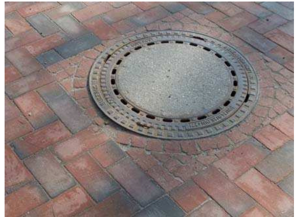
ABGESACKTE SCHACHTEINFASSUNG
