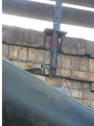
PFOSTENVERANKERUNG GELÄNDER
