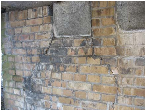
WIDERLAGERWAND OSTEN AUFLAGER NO
