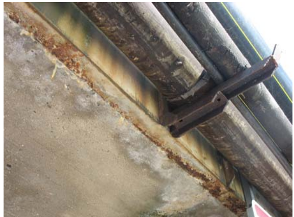
KONSOLEN FÜR ROHRLEITUNG
