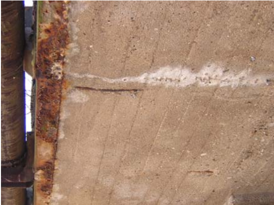
FREILIEGENDE BEWEHRUNG SÜDEN
