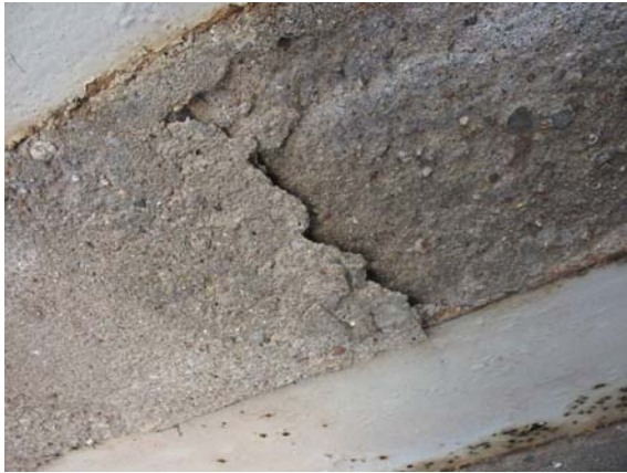
BETONGEFÜGE ZWISCHEN DEN WALZTRÄGERN
