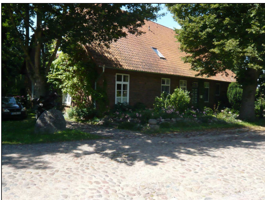
Abbildung 3 Historisches Meierei- Gebäude
