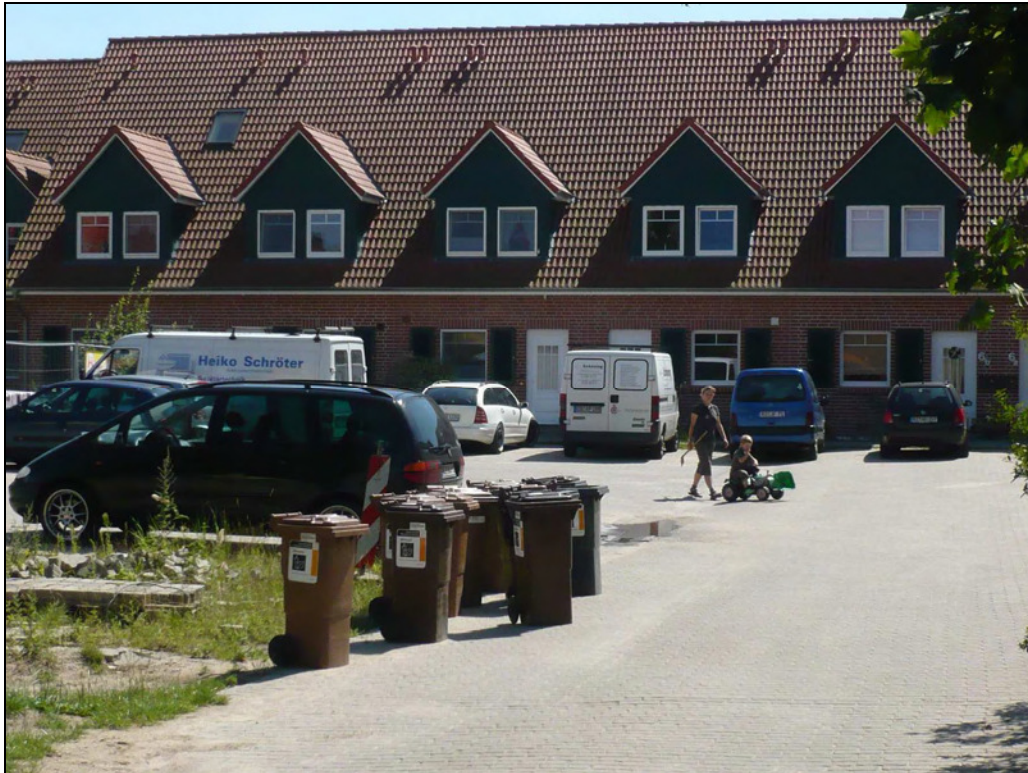
Abbildung 6 Hofsituation noch in Bauphase
