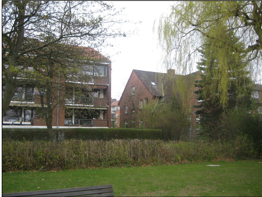
Abbildung 2: Ehemalige Jugendherberge (rechts) mit angrenzender Wohnbebauung von der Promenade aus gesehen
