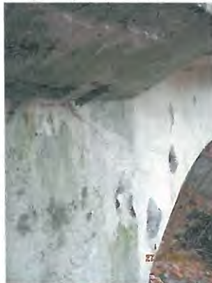
HP_2012_ACHSE10_AUSSINTERUNGEN
