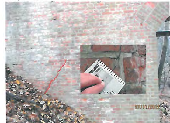
HP_2012_RISS_FLÜGELWAND_SW
