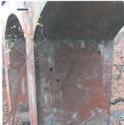
HP_2012_ANSICHTNORD_UNVERSCHLOSSENE_KERNBOHRUNGEN
