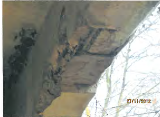
HP_2012_LÄNGSTRÄGER_SCHADHAFTE_INSTAN DSETZUNG_FELD3
