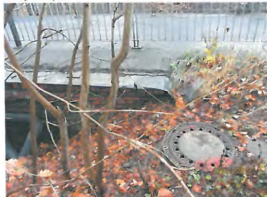
HP_2012_ABDECKUNG_BESCHÄDIGT_GESIMS_SO
