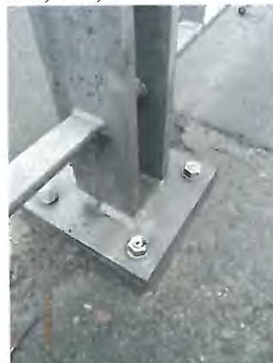
HP_2012_VERANKERUNG_GELÄNDER_VERBUNDANKER
