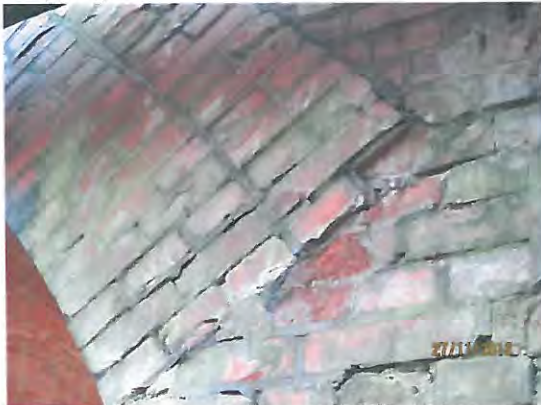
HP_2012_BOGEN_STIRNSEITE_MAUERWERK_GERISSEN
