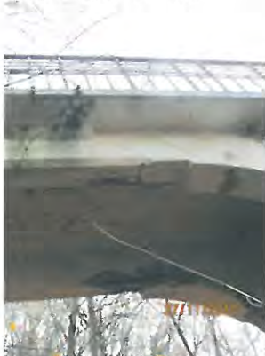
HP_2012_LÄNGSTRÄGER_ABPLATZUNG
