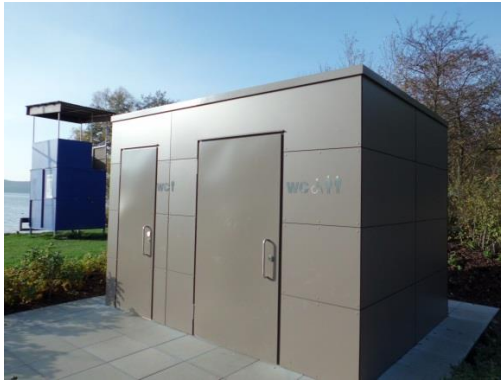
Abbildung 32 Barrierefreie Sanitäranlagen an der Bade- stelle „Aqua Siwa“ (Foto: GEWOS, 2013)
