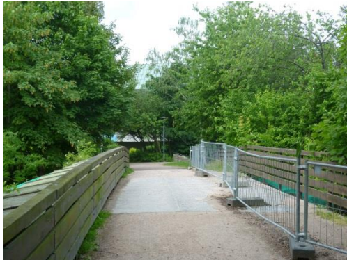
Abbildung 27 Ansicht der Kleinbahndammbrücke aus Blickrichtung des Kleinbahndammes (Foto: GEWOS, 2013)
