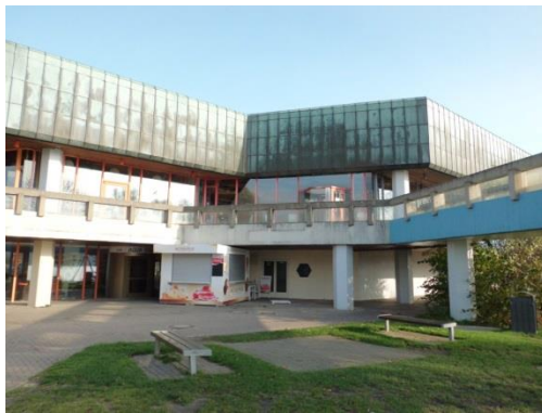
Abbildung 72 Rückansicht des Schwimmbads „Aqua Siwa“ am Südufer der Altstadtinsel (Foto: GEWOS, 2013)
