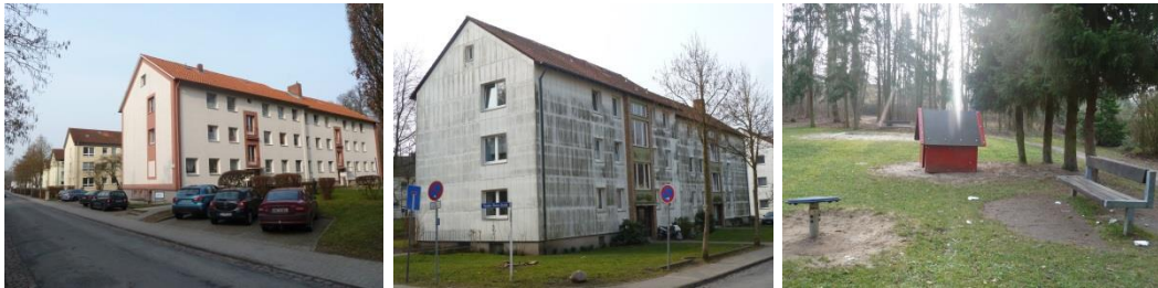
Fotos 31-33: Modernisierte und sanierungsbedürftige Zeilenbauten in der Berliner Straße, Spielplatz (Quartier 4)
