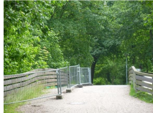
Abbildung 28 Ansicht der Kleinbahndammbrücke aus Blickrichtung des Schwimmbades „Aqua Siwa“ (Foto: GEWOS, 2013)
