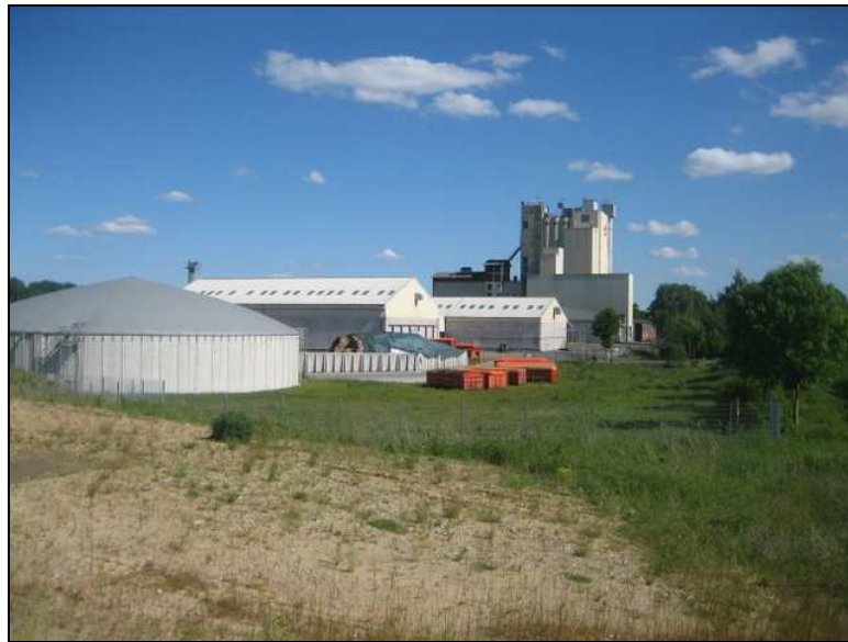
Abbildung 4: Bestehende Biogasanlage aufgenommen von der nördlich liegenden neuen Trasse der B 208
