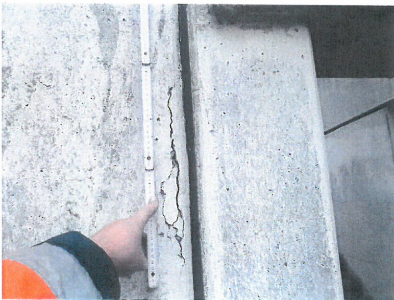
2015_BETONABPLATZUNG WAND
