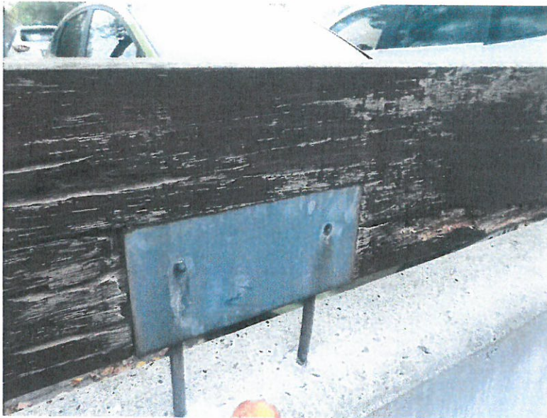
2015_BRÜSTUNGSBOHLE ANGEROTTET
