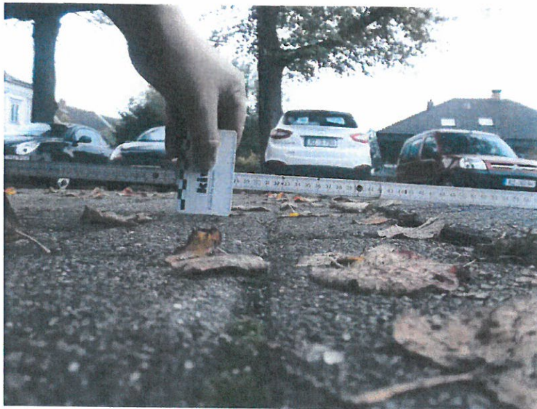
2015_SETZUNG IM FAHRBAHNBEREICH
