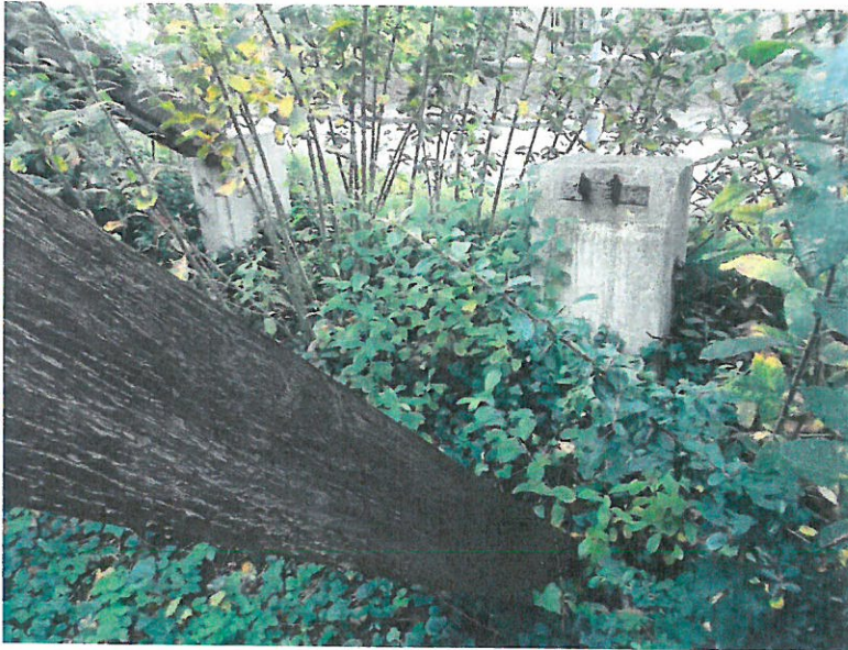
2015_BALKEN NICHT KRAFTSCHLÜSSIG
