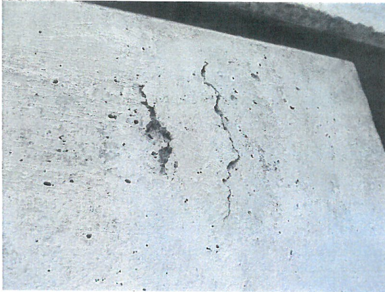
2015_BETONABPLATZUNGEN STÜTZWAND
