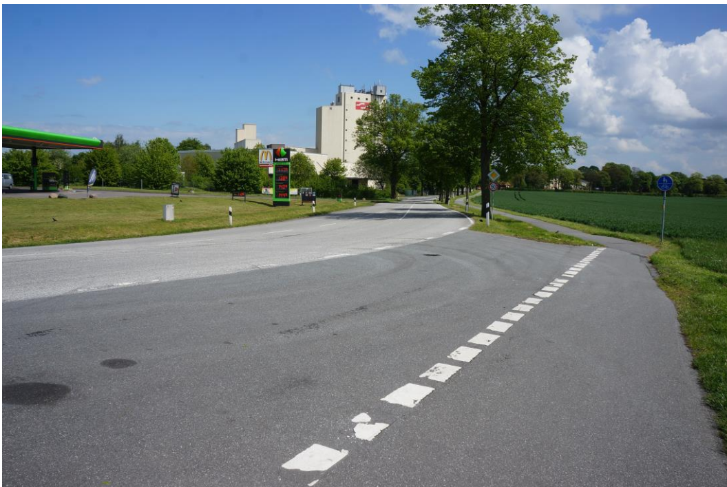
Südliche Bahnhofsallee, Blickrichtung Osten
