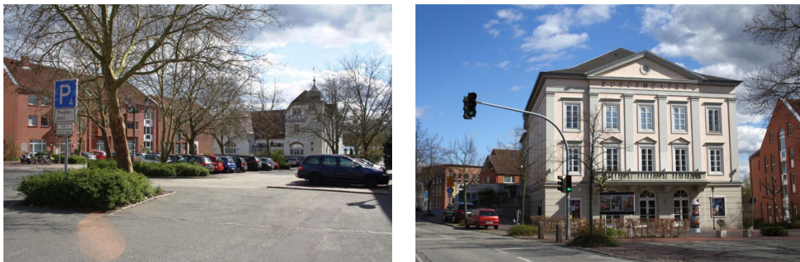
Abbildung 12: Theaterplatz mit Burgtheater (S.T.E.R.N. GmbH)
