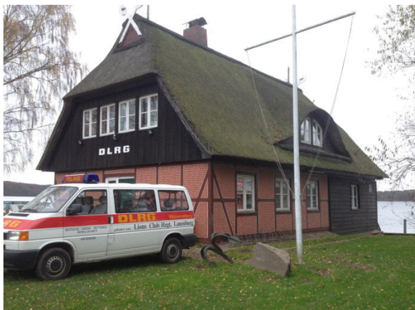
Abbildung 46: Gebäude des DLRG Ratzeburg e.V. (S.T.E.R.N. GmbH)
