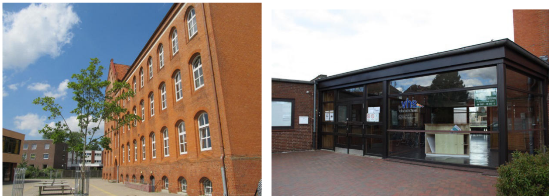
Abbildung 39: Hofseite und Eingangsbereich der ehem. Ernst-Barlach-Schule (S.T.E.R.N. GmbH)
