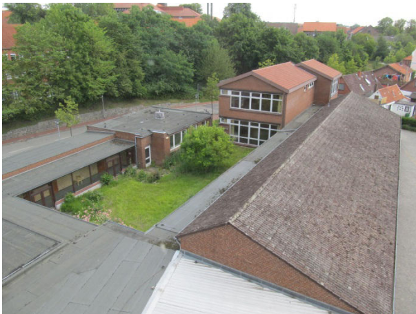
Abbildung 41: ein- bis zweigeschossige Anbauten (S.T.E.R.N. GmbH)
