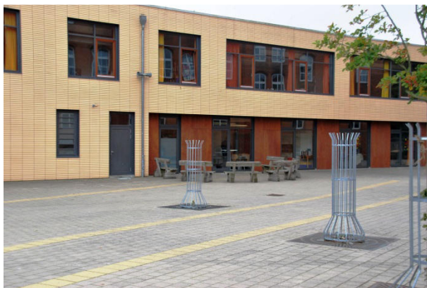
Abbildung 38: Schulgebäude und Pausenhof des Pestalozzi Förderzentrums (S.T.E.R.N. GmbH)
