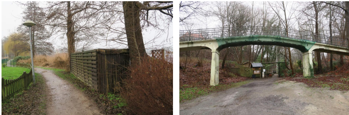
Abbildung 37: Weg am Ostufer ohne Blickmöglichkeit zum Ufer, gesperrte Kamelbrücke (S.T.E.R.N. GmbH)
