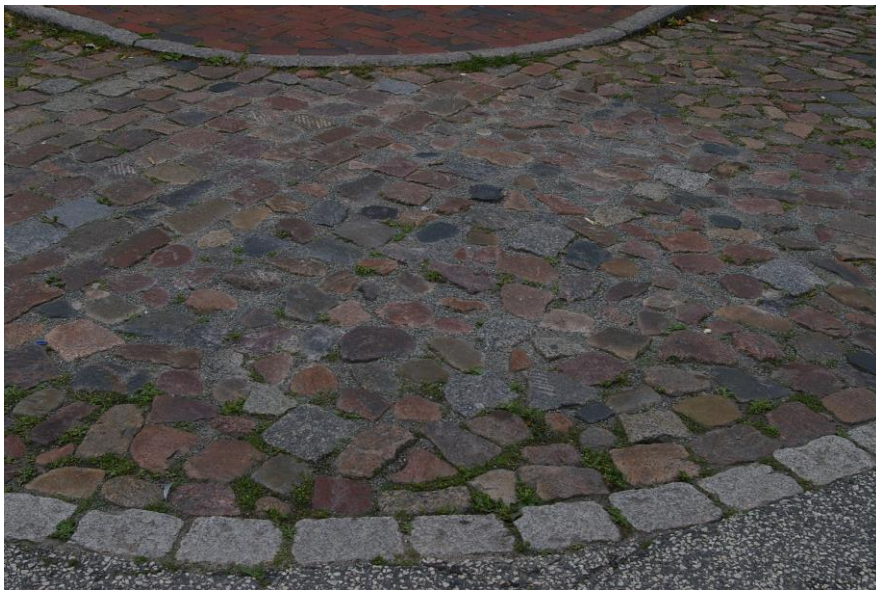
Bild 2: grobes Natursteinpflaster in Ratzeburg
