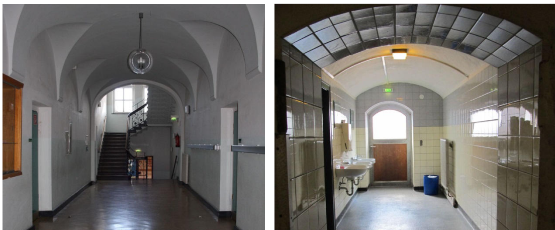
Abbildung 40: Flur und Sanitärbereich im Altbau (S.T.E.R.N. GmbH)
