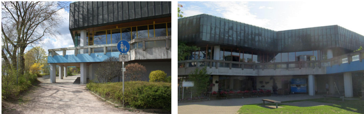
Abbildung 44: Schwimmhalle Aqua Siwa (S.T.E.R.N. GmbH)
