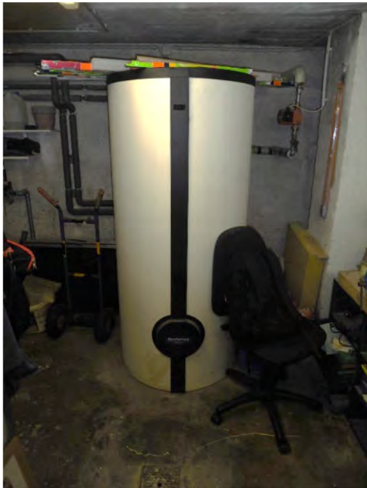
Bild 23 Anlagentechnik – Wasserspeicher
