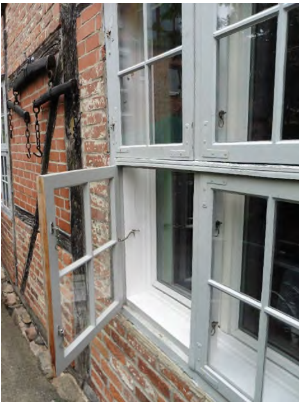
Bild 14 Südfassade Kastenfenster
