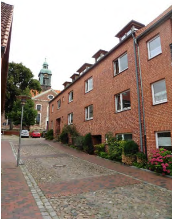
Bild 8 Gebäudeansicht – Bei St. Petri
