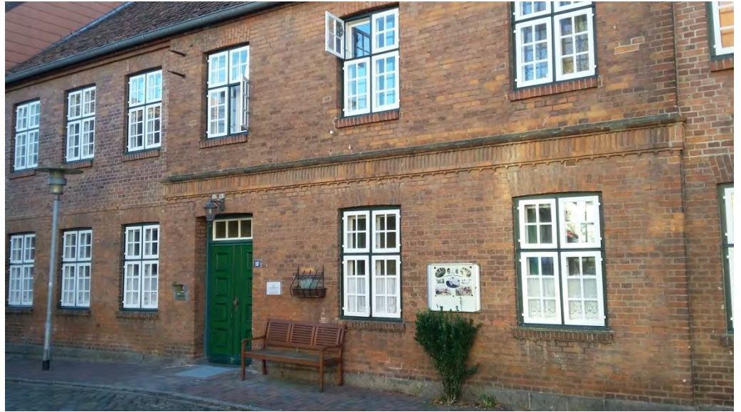
Ziegelmauerwerk der Außenwand zur Straßenseite Barlachplatz
