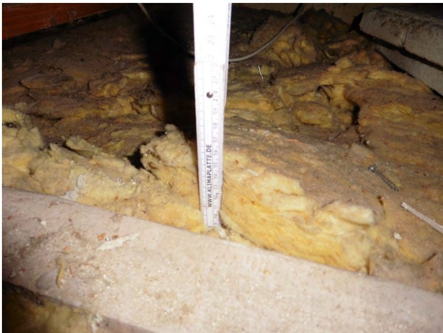
Bild 18 Oberste Geschossdecke – Dämmstärke
