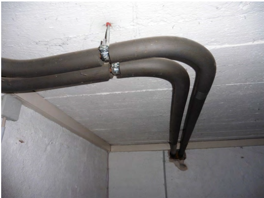
Bild 24 Anlagentechnik – Rohrleitungsdämmung
