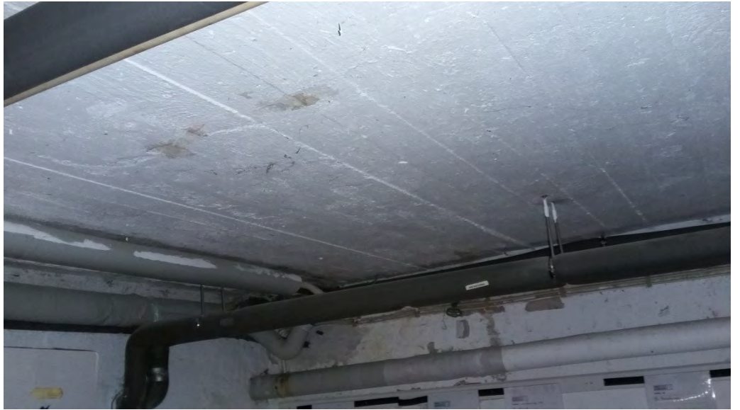
Unterseitige Deckenflächen im Kellergeschoss in Sichtbeton
