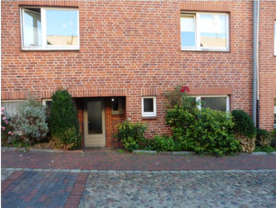
Bild 9 Westfassade – Wohnung Keller
