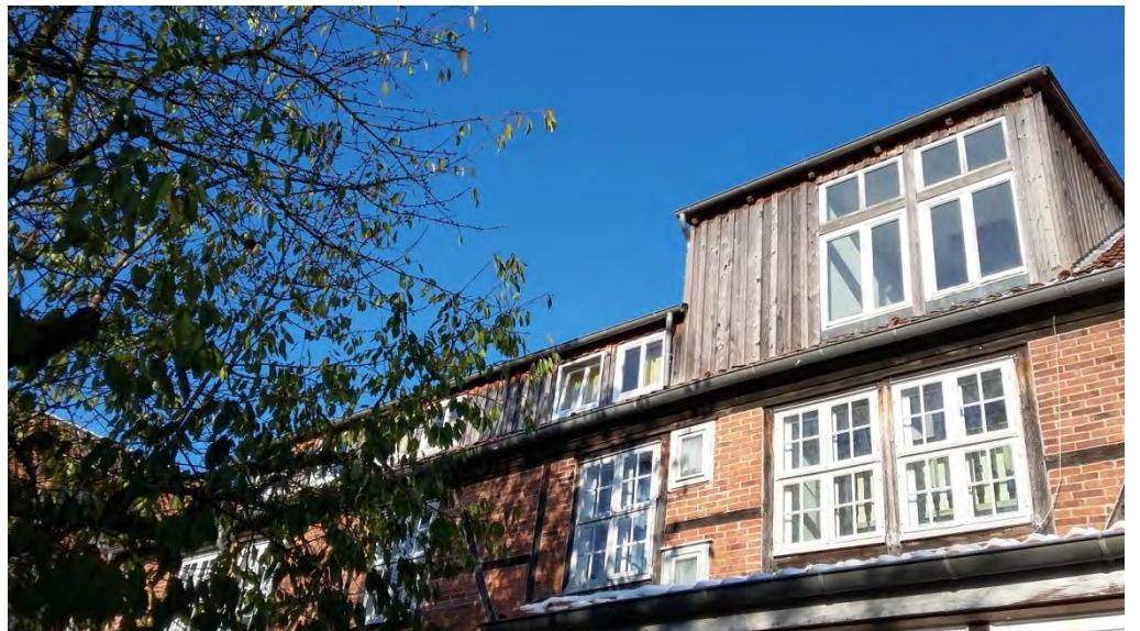
Dachfläche Hofseite durch Gauben geprägt
