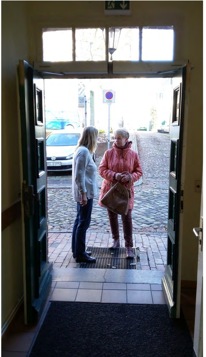
Oberlicht einfachverglast, Flügel ohne Dichtungen
