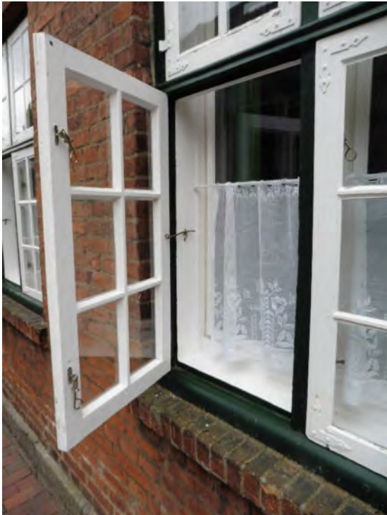
Bild 7 Nordfassade Kastenfenster
