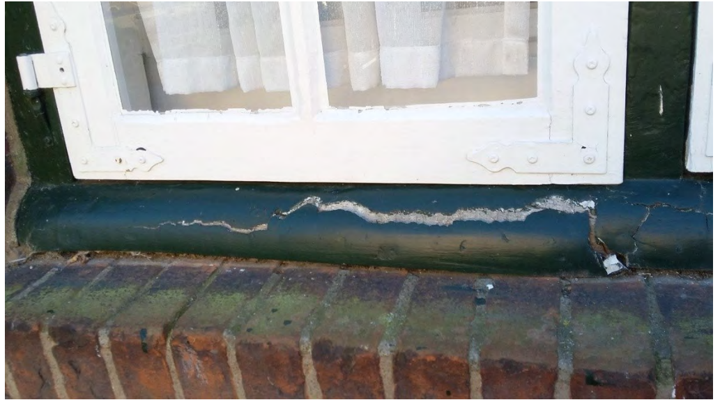
Detail Wetterschenkel am einfach verglasten Außenfenster zur Straße Barlachplatz
