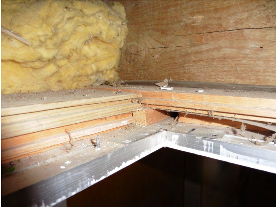
Bild 19 Oberste Geschosdecke – Dachbodenluke
