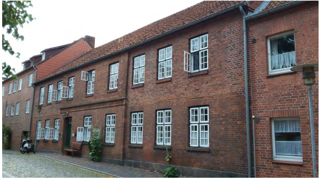
Historische Dacheindeckung an der Barlachstraße
