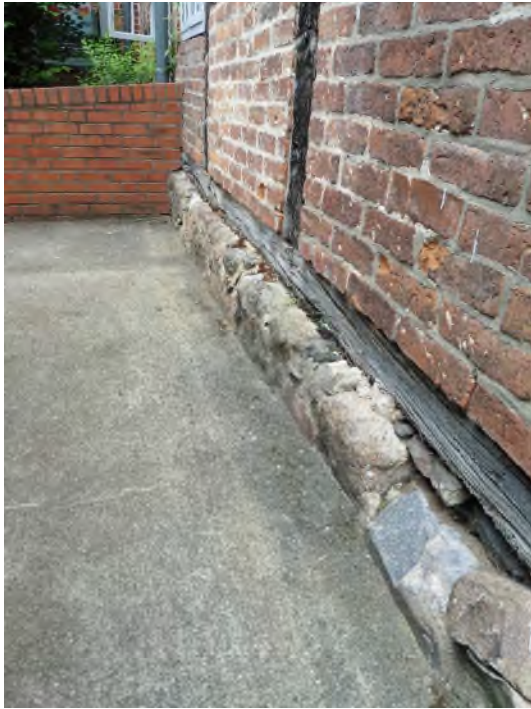
Bild 15 Südfassade Sockelschwelle
