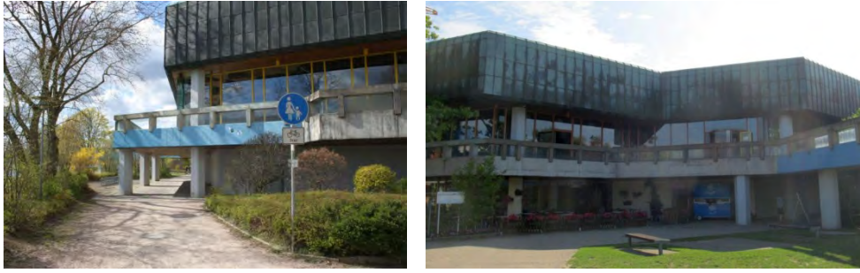
Abbildung 26: Schwimmhalle Aqua Siwa (S.T.E.R.N. GmbH)
