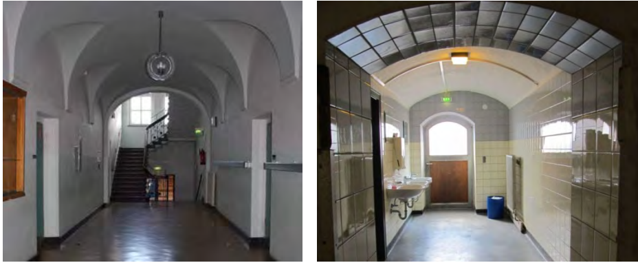
Abbildung 24: Flur und Sanitärbereich im Altbau (S.T.E.R.N. GmbH)
