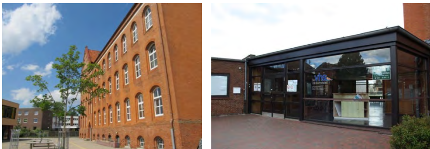
Abbildung 23: Hofseite und Eingangsbereich der ehem. Ernst-Barlach-Schule (S.T.E.R.N. GmbH)
