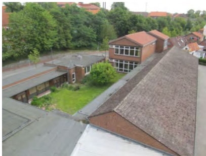
Abbildung 25: ein- bis zweigeschossige Anbauten (S.T.E.R.N. GmbH)
