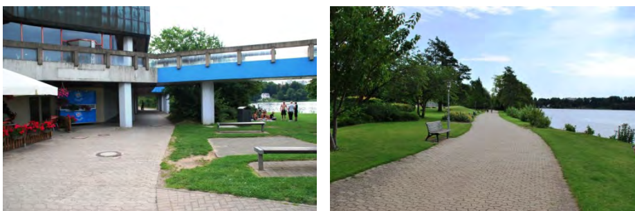
Abbildung 13: Schwimmhalle "Aqua Siwa" und Promenade im Kurpark (S.T.E.R.N. GmbH)
