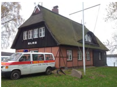
Abbildung 28: Gebäude des DLRG Ratzeburg e.V. (S.T.E.R.N. GmbH)
