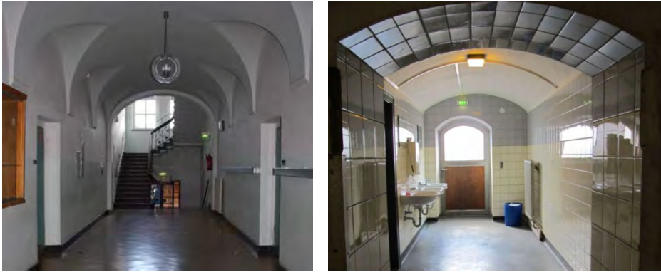
Abbildung 24: Flur und Sanitärbereich im Altbau (S.T.E.R.N. GmbH)
