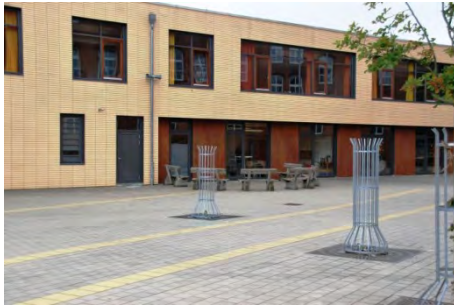
Abbildung 30: Schulgebäude und Pausenhof des Pestalozzi Förderzentrums (S.T.E.R.N. GmbH)
