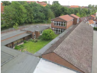
Abbildung 25: ein- bis zweigeschossige Anbauten (S.T.E.R.N. GmbH)
