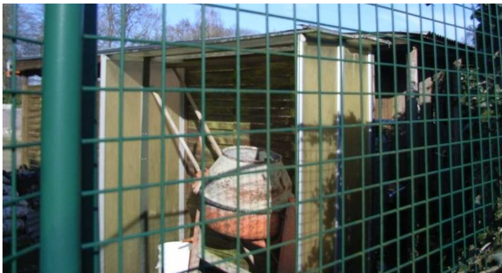
Abb. 6: Schuppen im Bauhofgelände als potentielles Fledermausquartier (Foto: F. Liedl)
