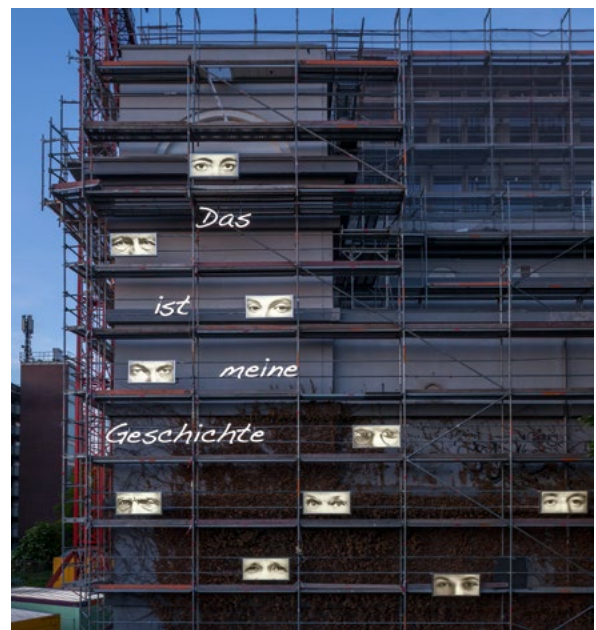
Kunstinstallation „Das ist meine Geschichte“ von Sabine Kammerl am Baugerüst während des Umbaus
