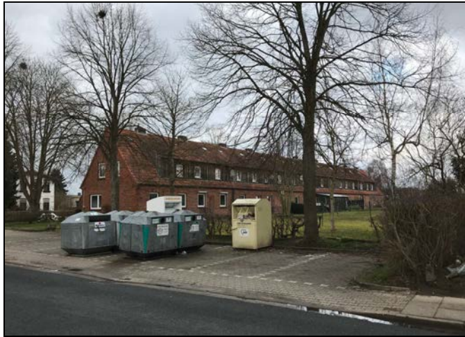
Abbildung 3: Rückwärtige Ansicht des 62 m langen Wohnblocks Seedorferstraße 25-33 (,von der Königsbergerstraße aus gesehen) mit vorgelagerten öffentlichen Parkplätzen und Recyclingstation
