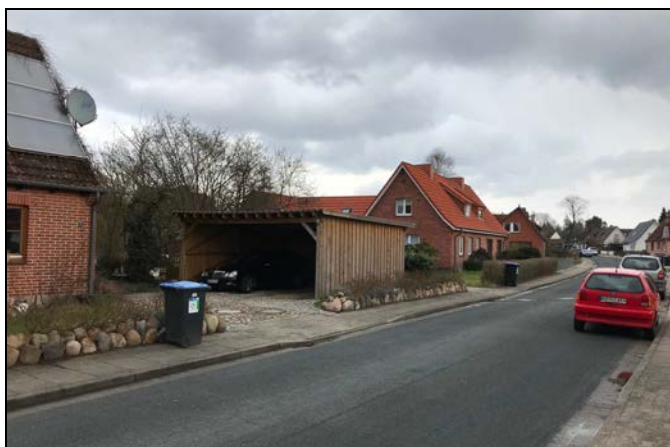
Abbildung 4: Vorhandene Doppelhausbebauung an der Königsberger Straße
