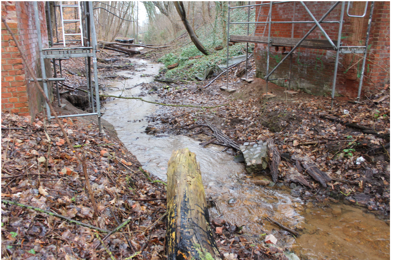
Abbildung 36: Unrat im Bachlauf
