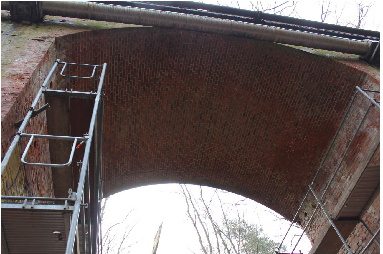
Abbildung 16: Gewölbe 2. Feld Unterseite
