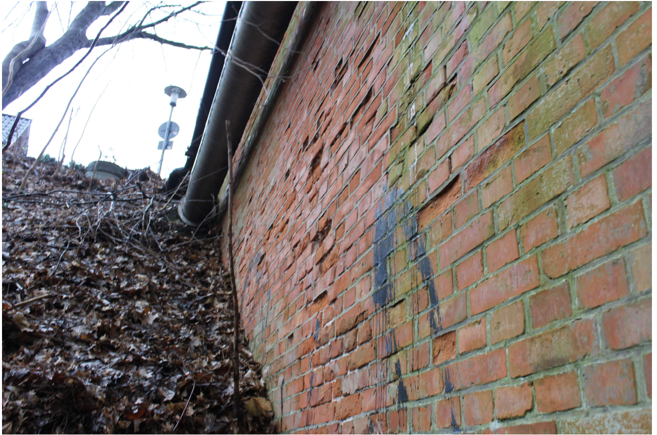
Abbildung 34: Abplatzungen/Farbspuren seitlich
