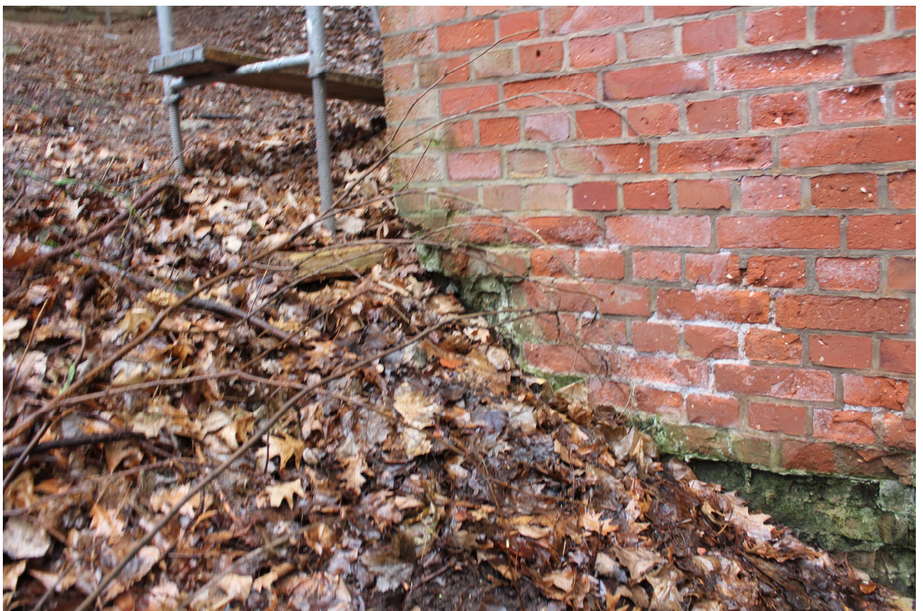
Abbildung 32: Querschnittsminderung Fußbereich
