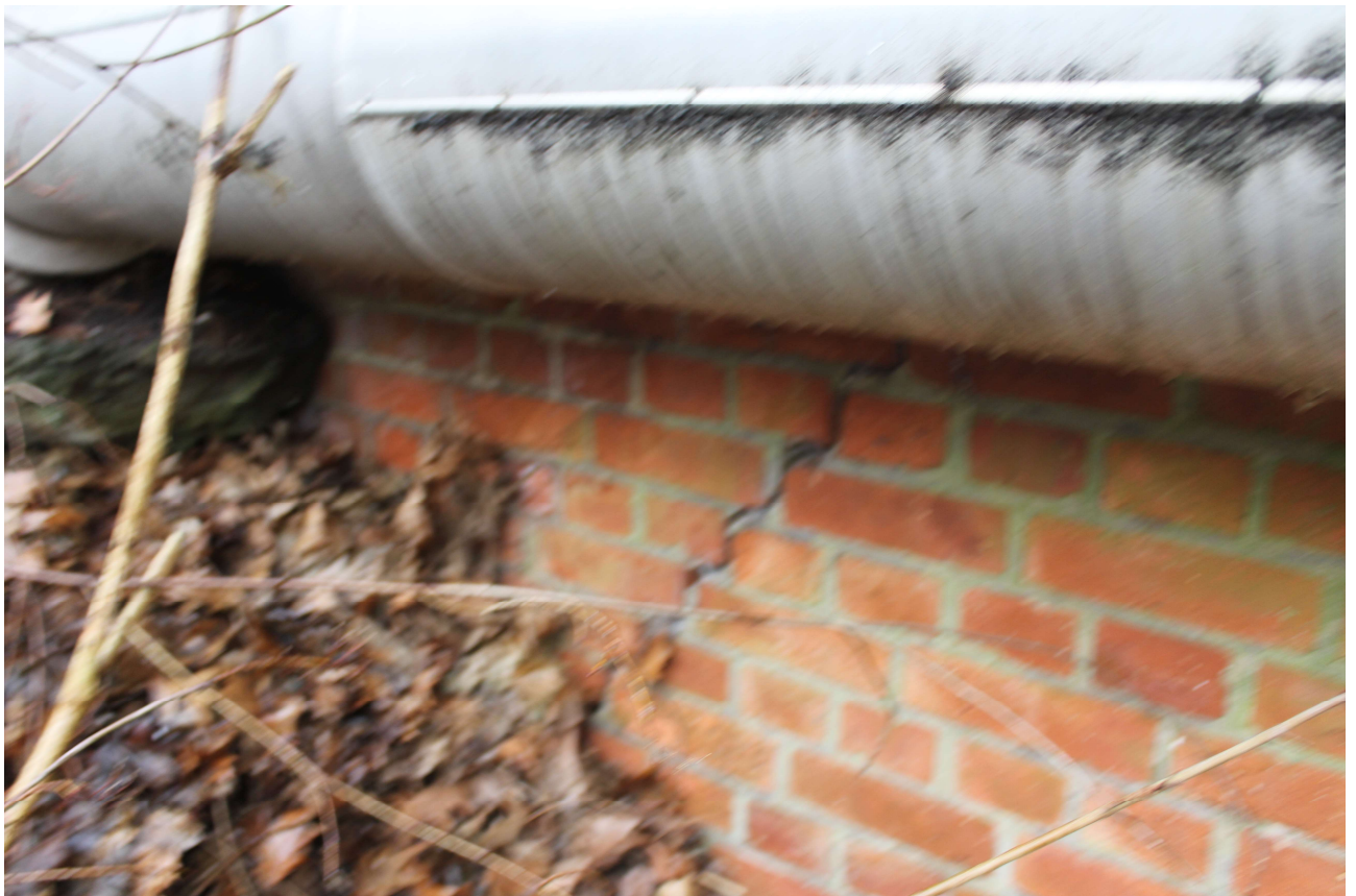
Abbildung 35: Riss Flügelwand
