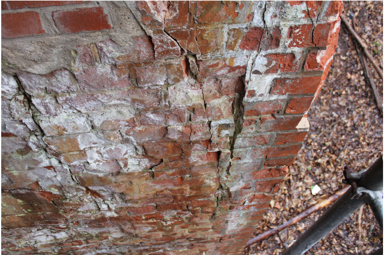
Abbildung 31: 2 Steinreihen lösen sich stirnseitig ab
