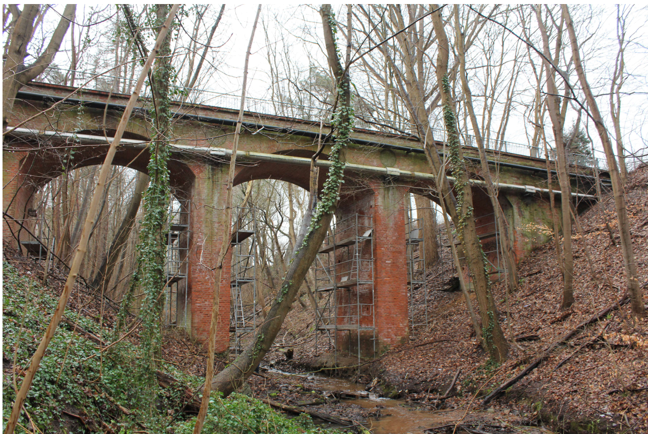
Abbildung 12: Gesamtansicht von Nord-West
