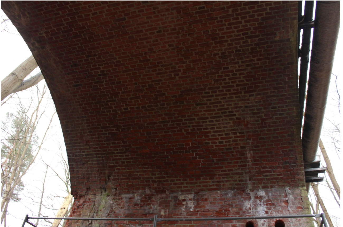
Abbildung 19: Gewölbe 3. Feld Untersicht (Blickrichtung nach Süd-West)
