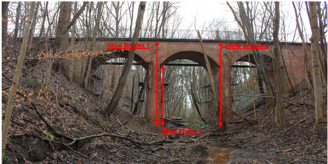
Abbildung 8: Ansicht von Süd-Ost - Brückenhöhe
