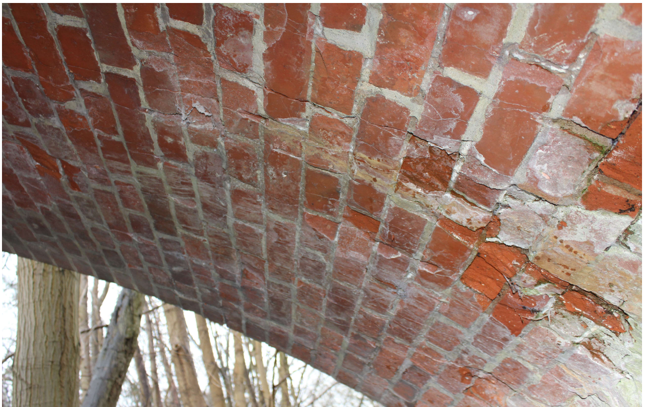
Abbildung 20: Nahaufnahme Abplatzungen/Aussinterungen
