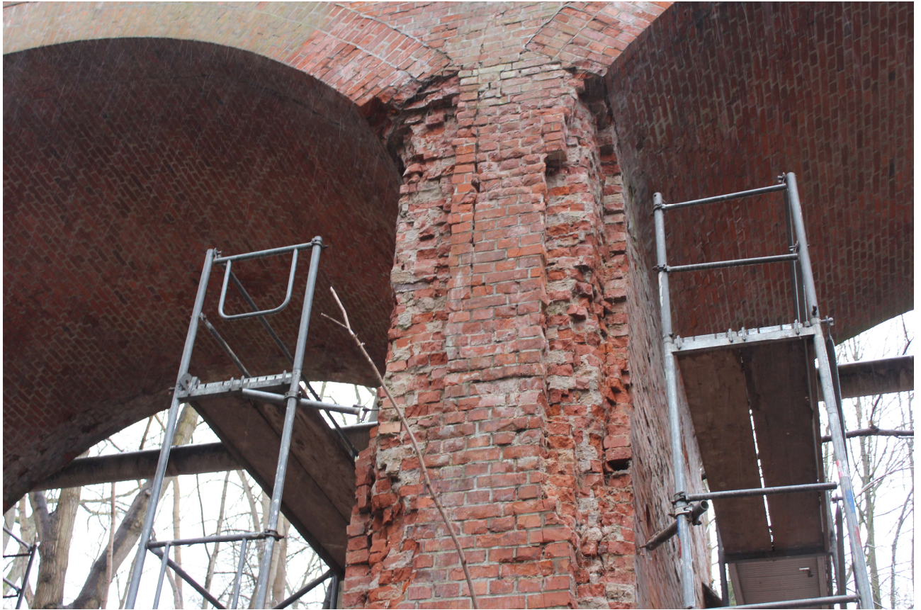
Abbildung 26: Pfeiler vorne Ansicht Süd-Ostseite
