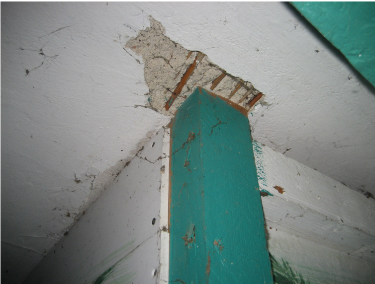
Decke zum Spitzboden Raum 0.17
