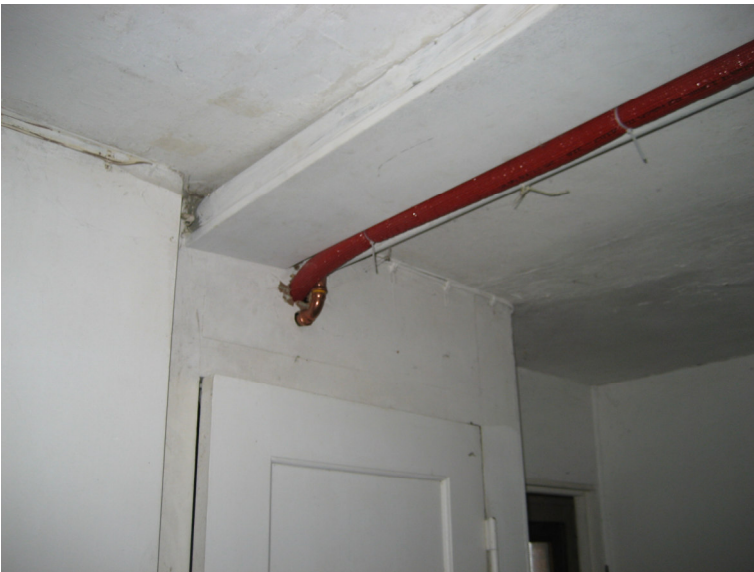
Kellertür It5 und Deckenansicht
