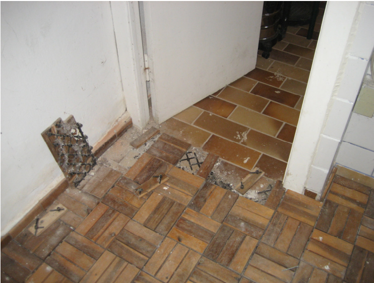
Holzfliesen auf Bodenfliesen Raum 0.07
