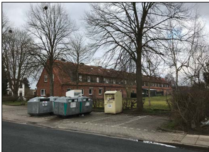
Abbildung 5: Rückwärtige Ansicht des 62 m langen Wohnblocks Seedorferstraße 25-33 (von der Königsbergerstraße aus gesehen) mit vorgelagerten öffentlichen Parkplätzen und Recyclingstation
