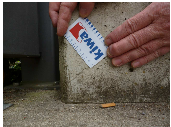
2021_ RISS IM RIEGEL
