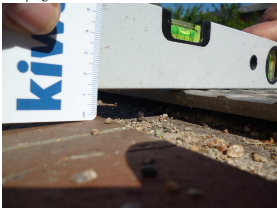
2021_SCHLEPPBLECH SCHIEFSTELLUNG
