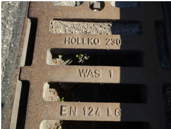
2021_BAUWERKSENTWÄSSERUNG VERSCHMUTZT
