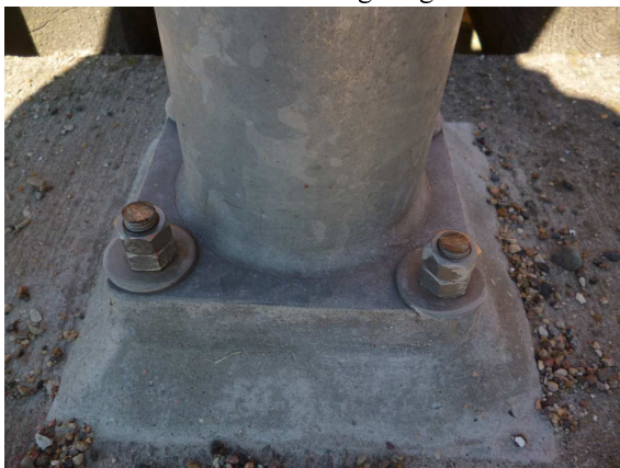
2021_BOLZEN ABGETRENNT
