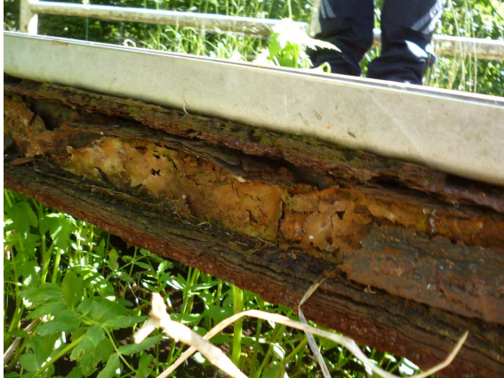
2021_TRÄGER KORRODIERT
