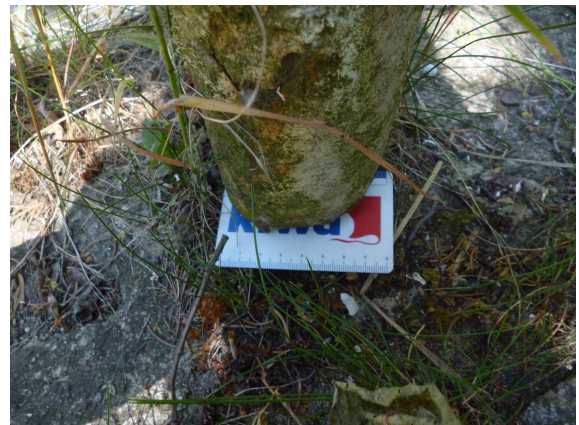
2021_DURCHKORRODIERTE PFOSTENFÜSSE
