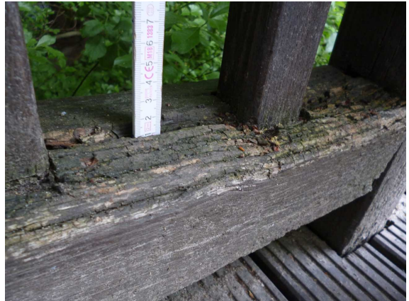
2021_VERROTTUNGSERSCHEINUNGEN AM FUSSHOLM
