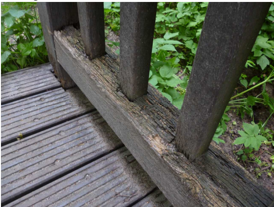
2021_GELÄNDERPFOSTEN VERMODERT
