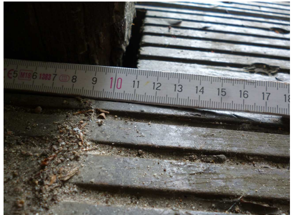
2021_PFOSTEN MIT QUERSCHNITTSVERLUST
