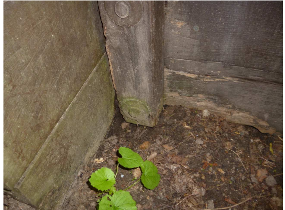
2021_PFOSTEN MIT ERDKONTAKT
