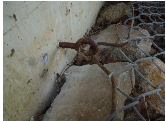
2021_KORROSION ANKERÖSEN
