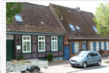
Schulstraße: typischer Gebäudemaßstab
