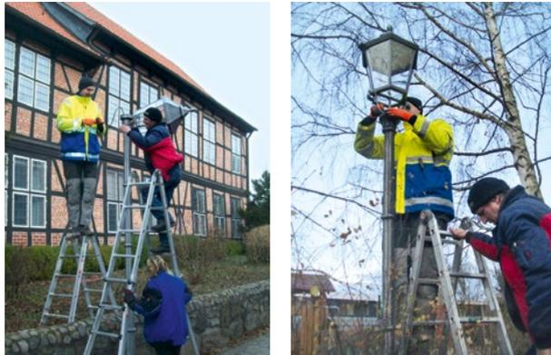
Die neuartigen LED-Lampen zeichnen sich durch eine hohe Energieeffizienz und lange Lebensdauer aus. Mit ihrem Einsatz kann der Verbrauch pro Leuchte bei nahezu gleicher Lichtausbeute von 80 auf 24 Watt reduziert werden. Ihre längere Lebensdauer führt überdies zu einer Verlängerung der Wartungsintervalle um mindestens das Fünffache und spart so teure Arbeitskosten.
