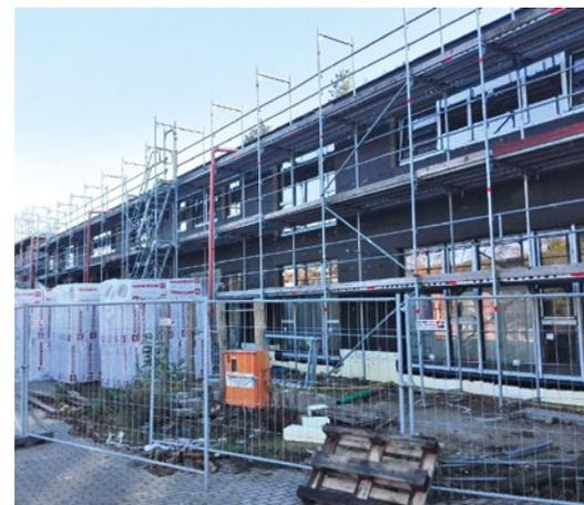
Eine energetisch gedämmte Fassade wird mit dem neuen barrierefreien Flurvorbau errichtet.
