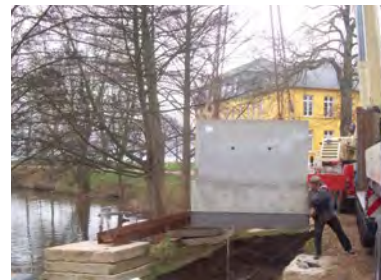
Einbau eines Regenwasserklärbeckens am Lüneburger Damm in 2015.
