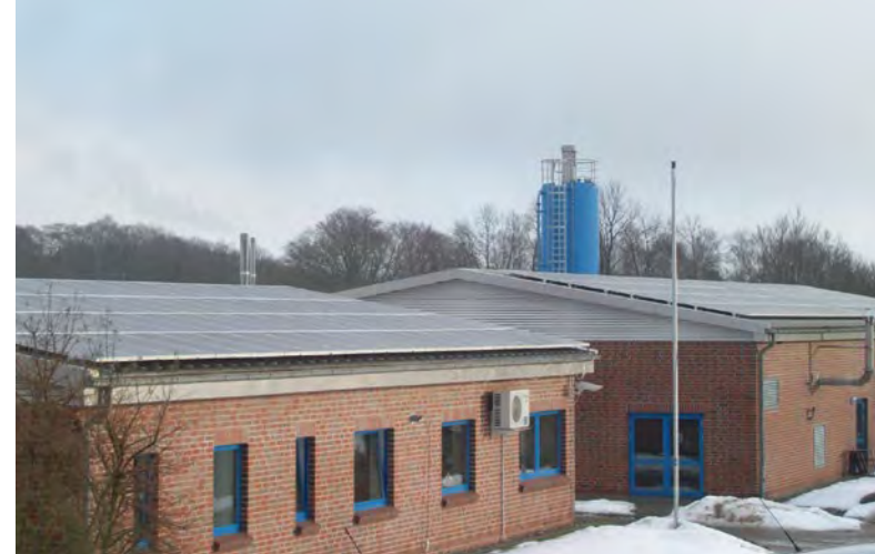
Die neue Photovoltaikanlage mit 186 monocrystallinen Solarmodulen liefert 38.000 kWh Elektroenergie für den Eigenverbrauch des Klärwerks
