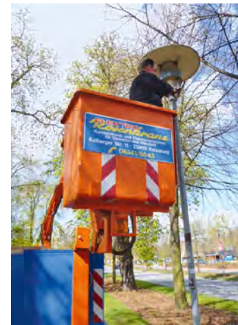
Ausgedient nach 25 Dienstjahren ... eine Quecksilberdampfleuchte.
