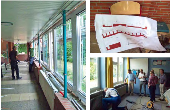
Energetische Sanierung der Grundschule St. Georgsberg.
