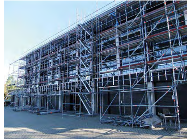
Energetische Gebäudesanierung der Ruderakademie Ratzeburg
