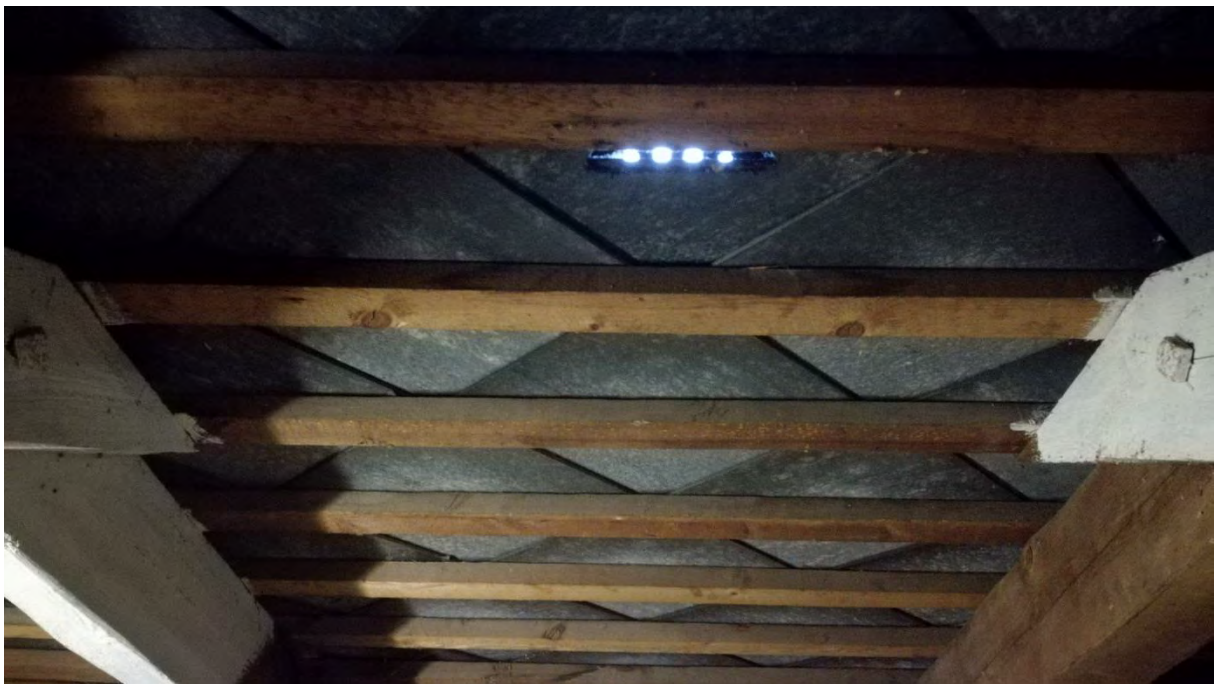
Dachabdeckung von innen, dicht und Lüftungssteine nicht für Fledermäuse passierbar.
