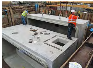
Einbau eines Regenwasserklärbeckens am Lüneburger Damm in 2015.
