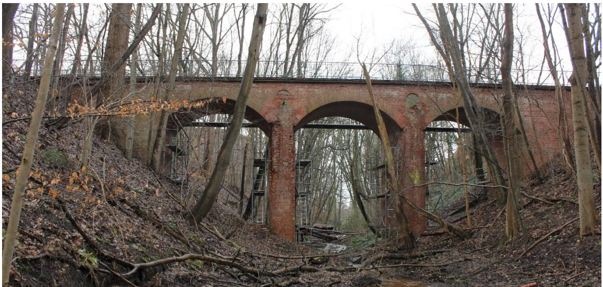
Abbildung 1: Dreifeldbogen Brücke Röpersberg - Ansicht von Süd-Ost, eigene Aufnahme vom 24.02.2020
