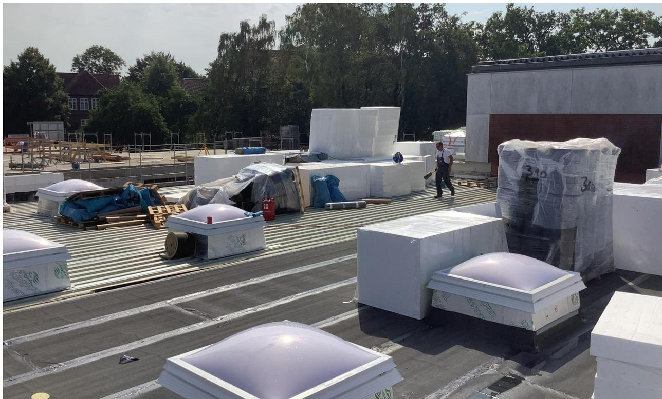
Abbildung 2: Dachabdichtungsarbeiten Sporttrakt
