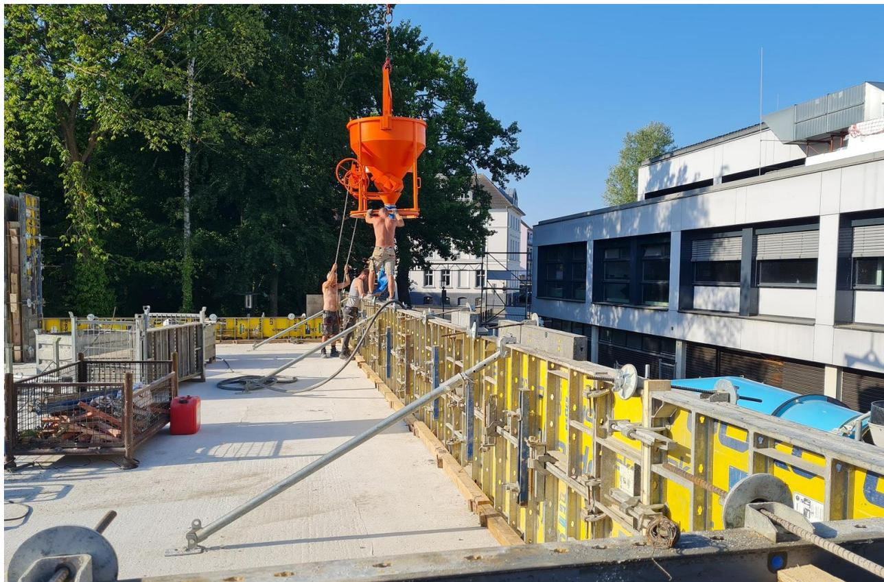
Abbildung 1: Betonieren des Überzugs Decke Ostflügel
