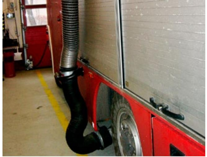
Bild 27 Regelkonform installierte Abgasabsaugung
