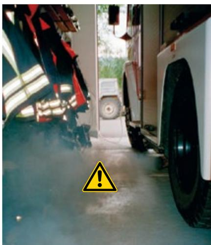
Idealerweise schaltet sich die Abgasabsauganlage automatisch an. Ist das nicht der Fall, soll die Steuerung der Abgasabsaugungsanlage leicht und schnell erreichbar sein. Es hat sich bewährt, z. B. mit dem Alarmschalter am Eingang in das Feuerwehrhaus (zum Einschalten der Übersichtsbeleuchtungen der Alarmwege) auch die zeitgesteuerte Abgasabsauganlage einzuschalten.
