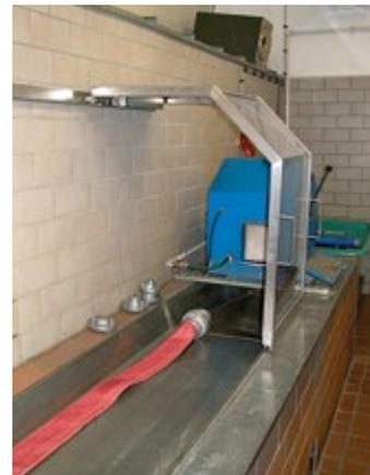
Fußböden in Schlauchpflegewerkstätten müssen rutschhemmend, schlagfest und waschfest sowie frei von Stolperstellen ausgeführt werden. Wasseransammlungen auf dem Boden müssen vermieden werden. Hierfür benötigte Bodenabläufe sind trittsicher und bodengleich auszuführen.
