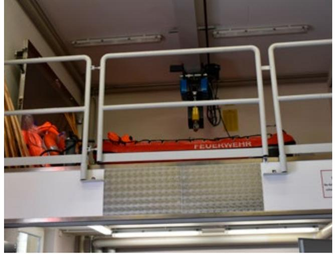
Bild 43 Zwischenboden (Fußleiste, Steckgeländer)
