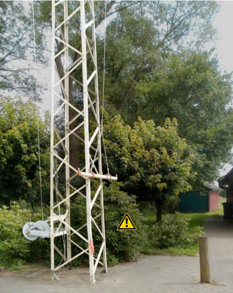
Bild 50 Ungesicherter Schlauchmast neben dem Feuerwehrhaus
