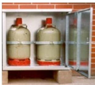
Bild 44 Kleinlager für Flüssiggasflaschen im Freien
