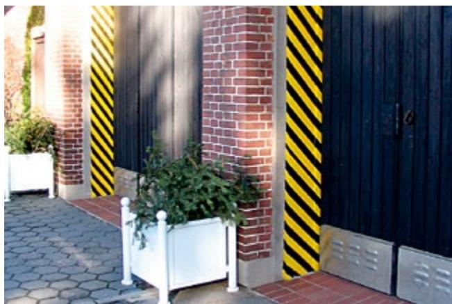
Bild 23 Kennzeichnung der Torlaibungen bei fehlenden Sicherheitsabständen
