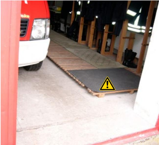
Bild 17 Diese Konstruktion birgt Umknick- oder Stolpergefahr
