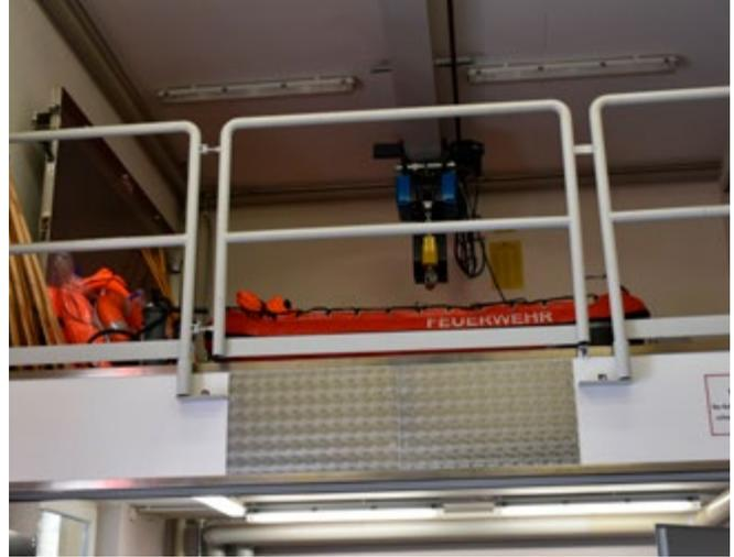
Bild 43 Zwischenboden (Fußleiste, Steckgeländer)
