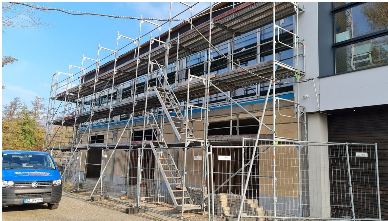
Abbildung 1: Holzbeplankung im Westflügel Seeseite
