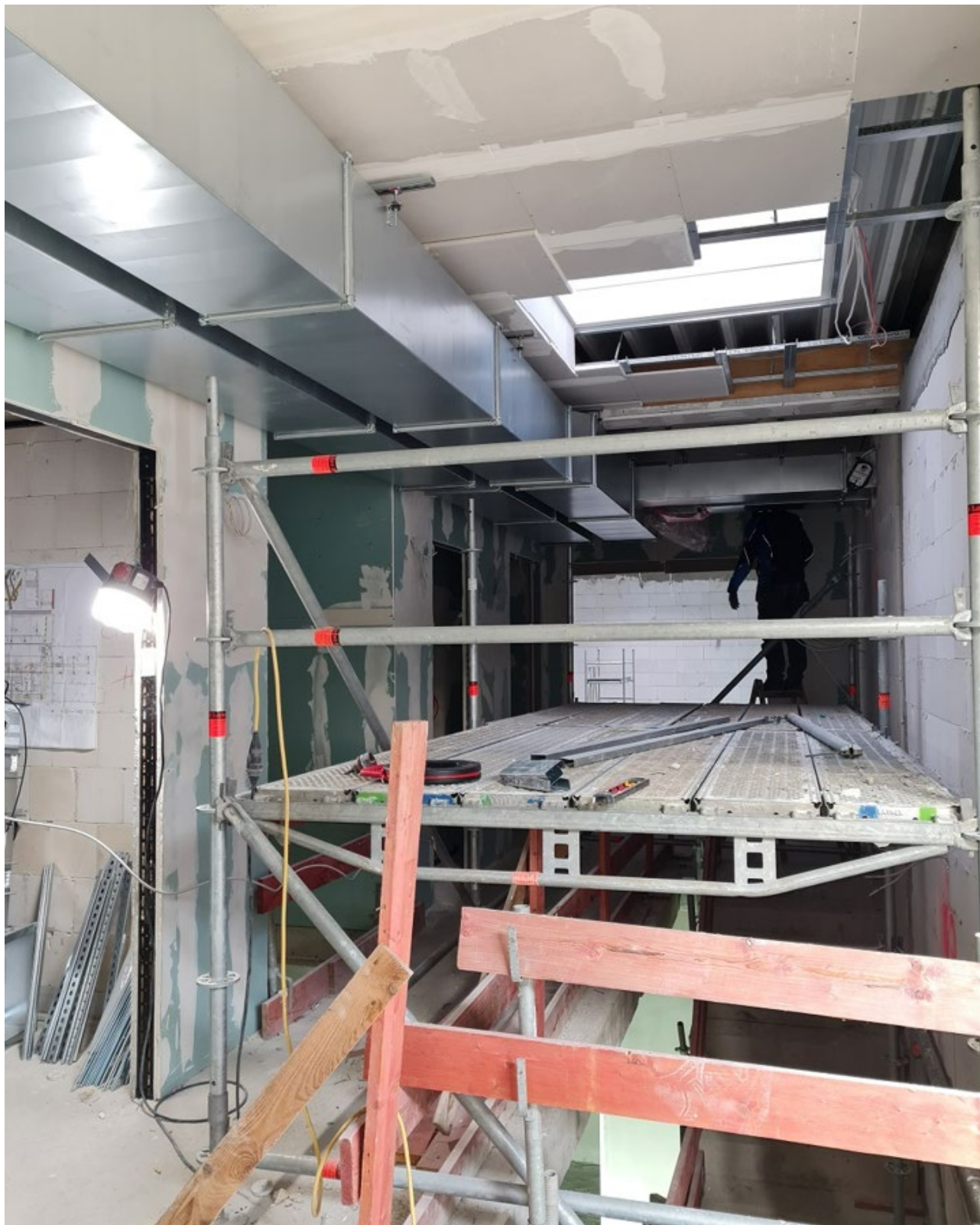
Abbildung 3: Installation Leitungskanäle
