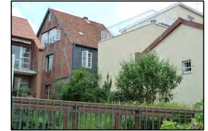
Abb.24, 25: Rückwärtige Anbauten in nicht einsehbaren Bereichen
