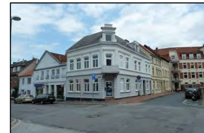
Abb.11: Große Kreuzstraße: typischer Gebäudemastab
