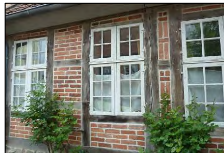
Abb.42: Fenster in Fachwerkfassade
