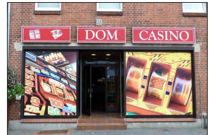
Abb.77: So nicht! – Leuchtkästen, vollflächig verklebte Schaufenster
