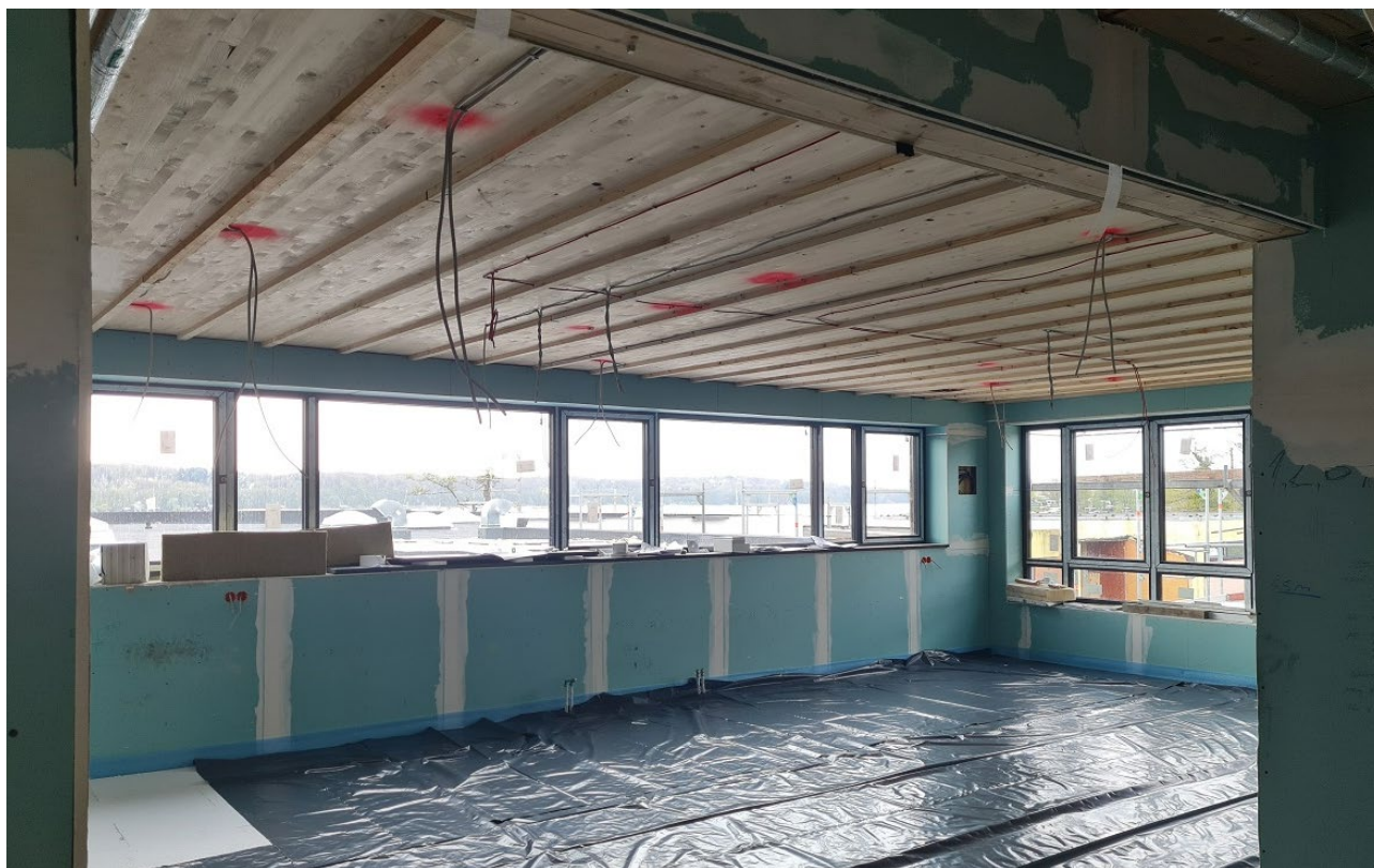
Abbildung 5: Einbau Deckenplatten
