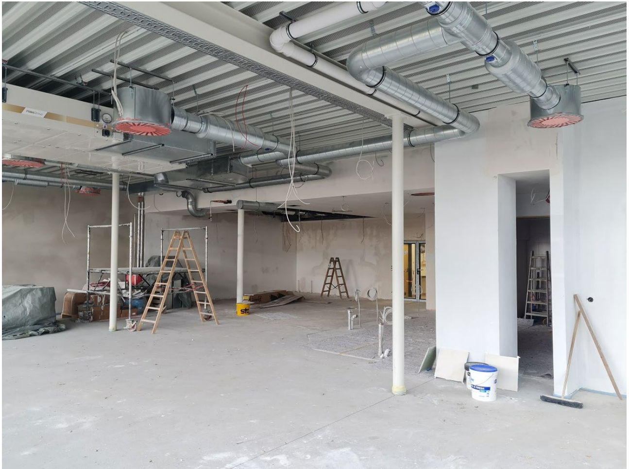
Abbildung 2: Einbau Lüftungsgeräte
