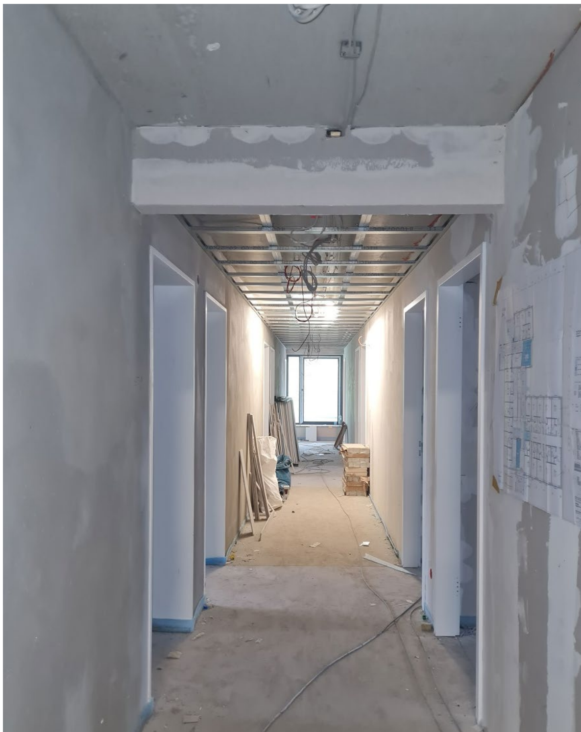
Abbildung 4: Trockenbauarbeiten
