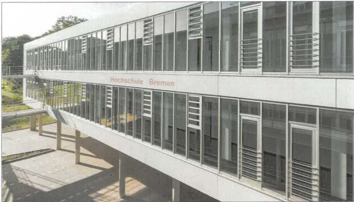
Beispiel für einen aufgeständerten Modulbau an der Hochschule Bremen (Schriftzug einmontiert)
