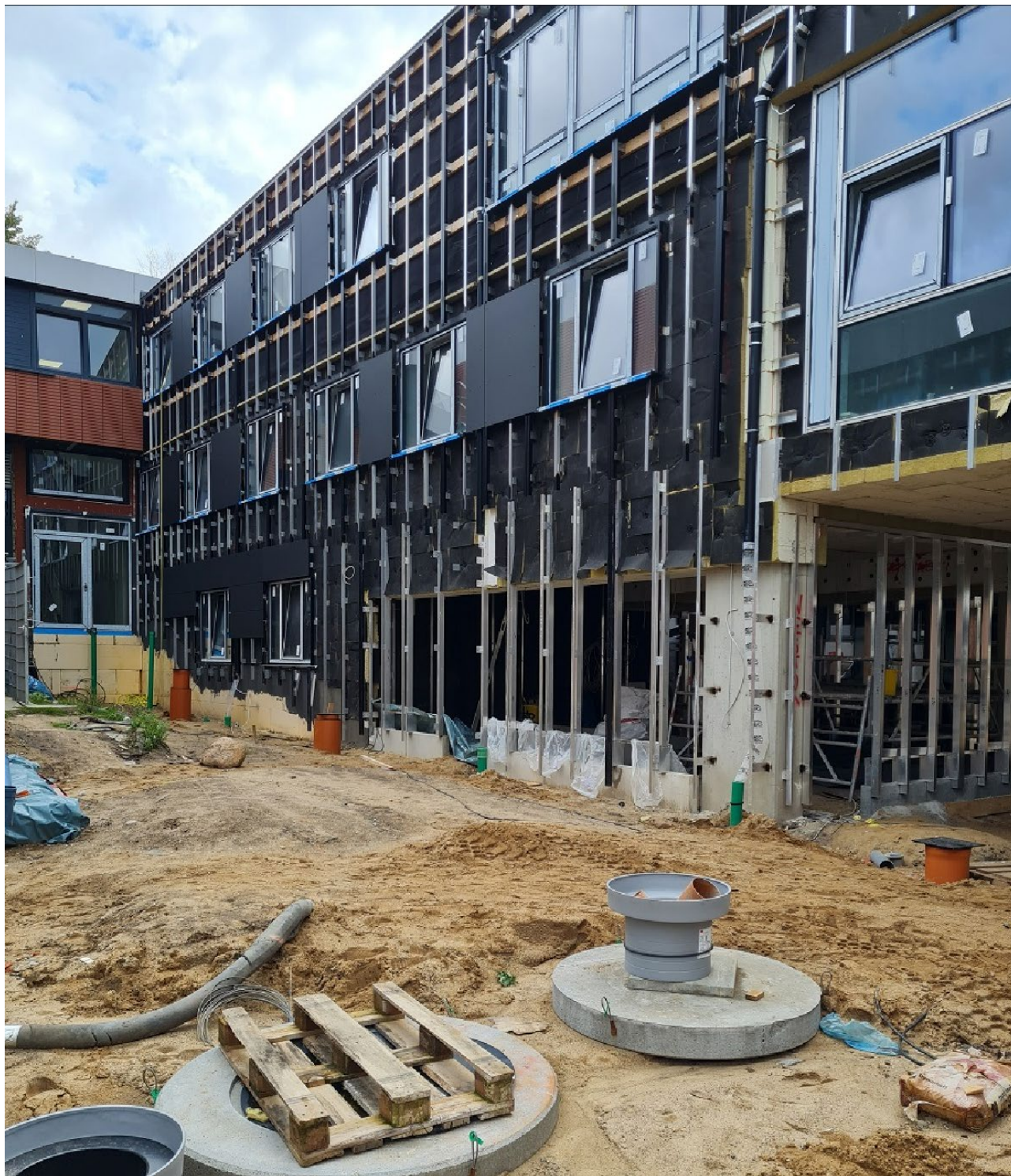
Abbildung 1: Blick auf die Außenfassade: Wohnen / Crossover.
