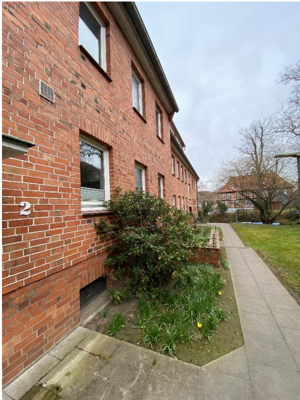
Foto 1: Östliche Außenwand der Wasserstraße 2A.
