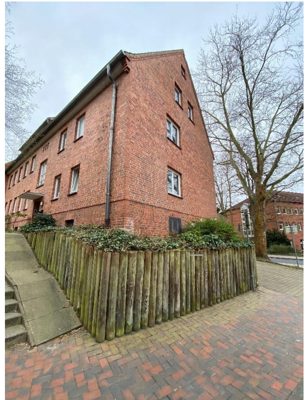
Foto 6: Nördliche Außenwand mit älterer Platane an der Wasserstraße 2A.
