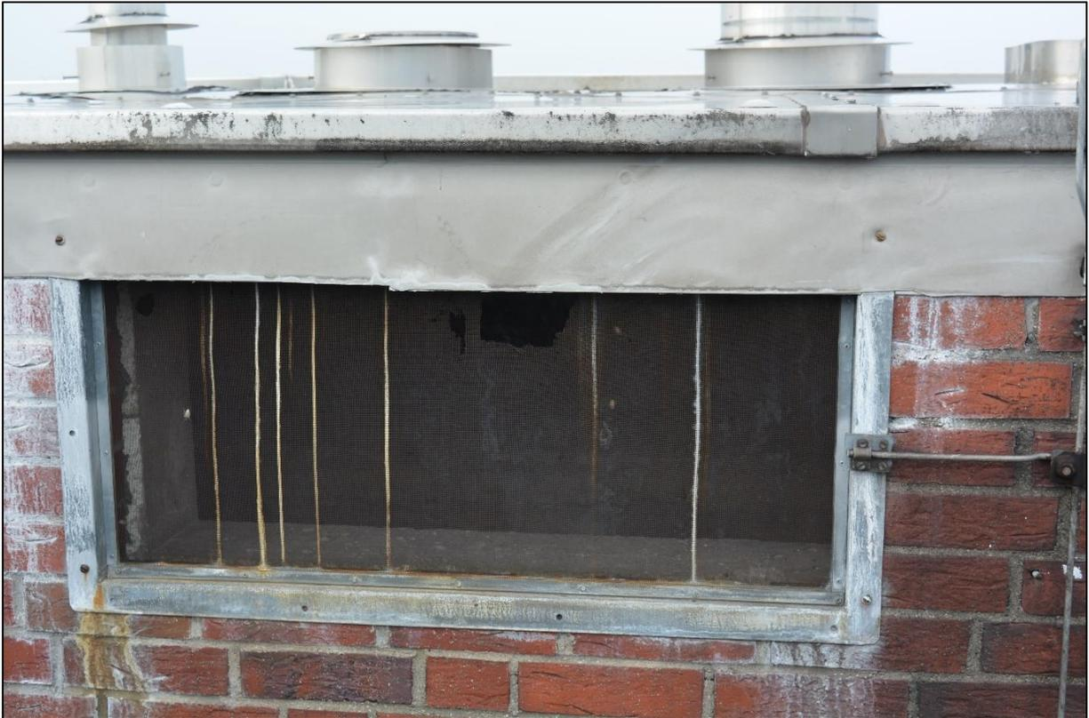
Abbildung 13: Beschädigtes Gitter an einem Heizungsschacht des höchsten Gebäudes. Foto: © LEWATANA, 2024
