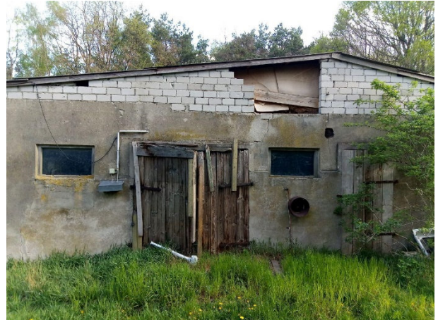
Abb. 19: Ehemaliges Stallgebäude (Pferdestall 1), 26.04.2019
