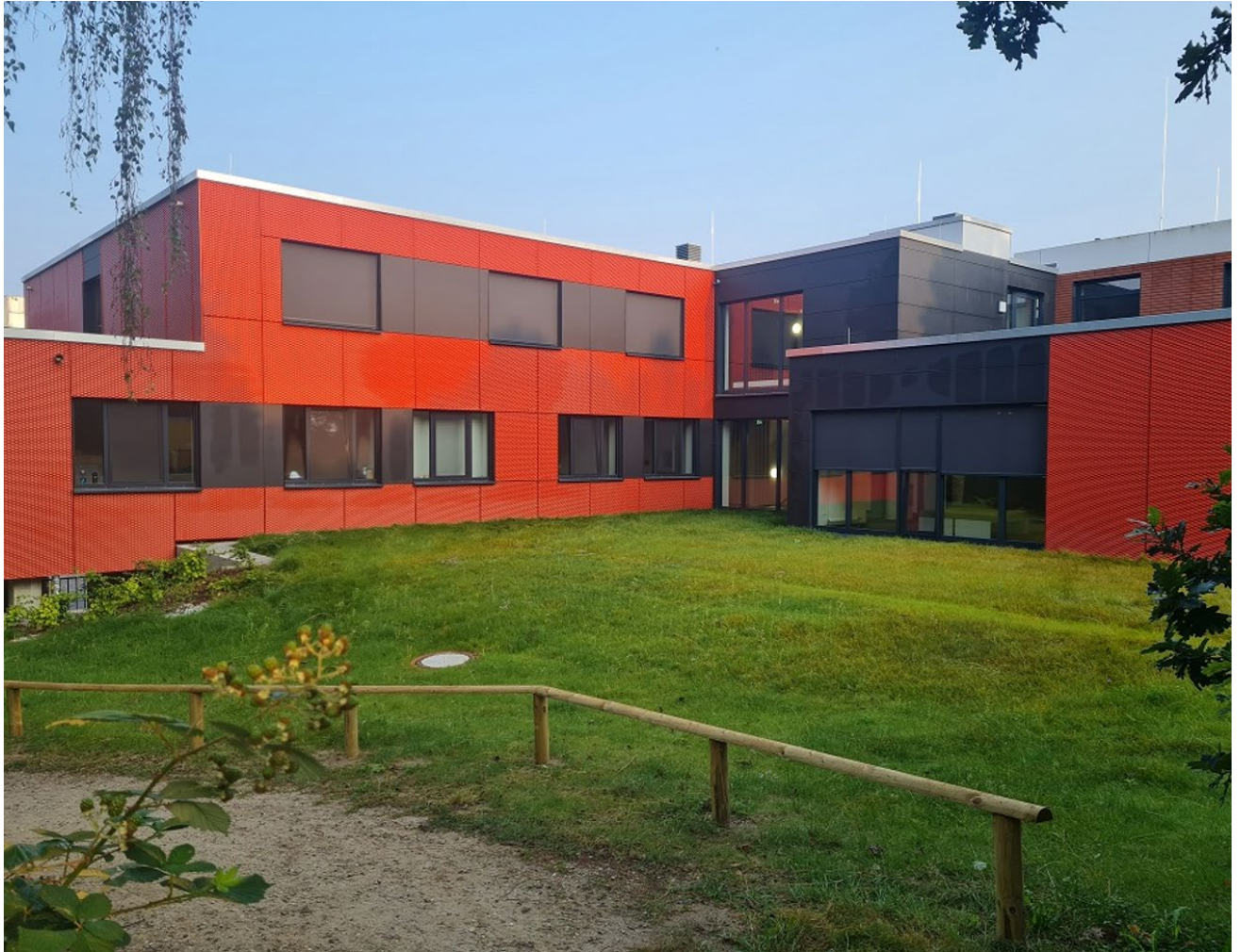
Abbildung 2: Ansicht Neubau Rückseite
